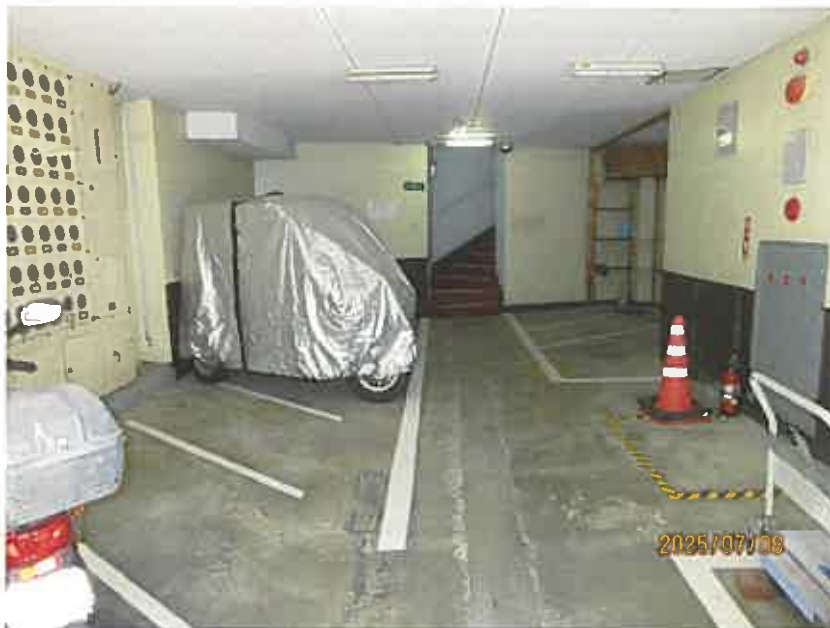
写真 1 2 オートバイ置場（2号館）
