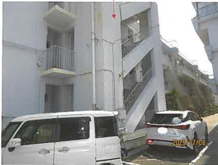
一棟の建物（1号館）
