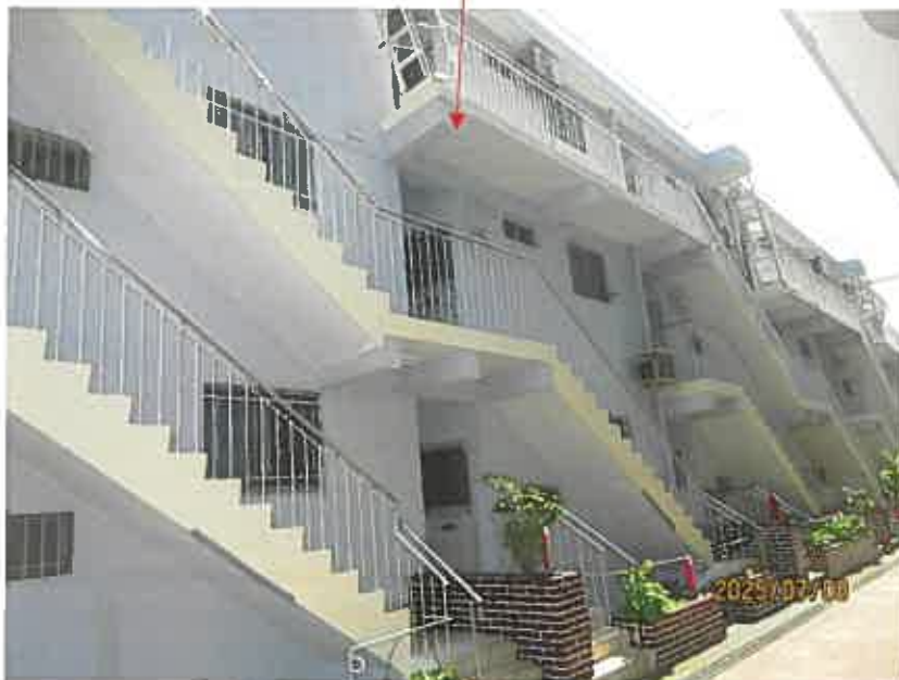
一棟の建物（1号館）
