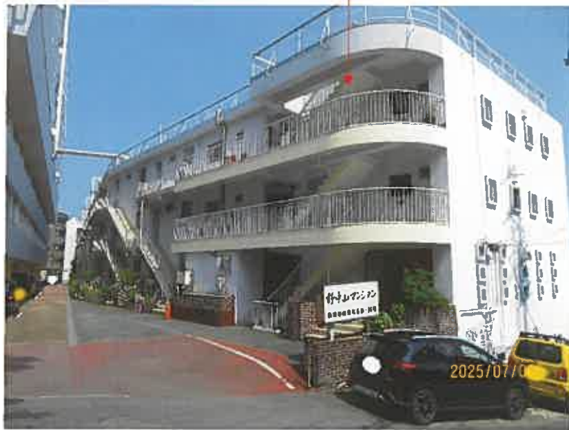
一棟の建物（1号館）
