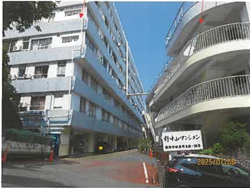
一棟の建物（1号館）
