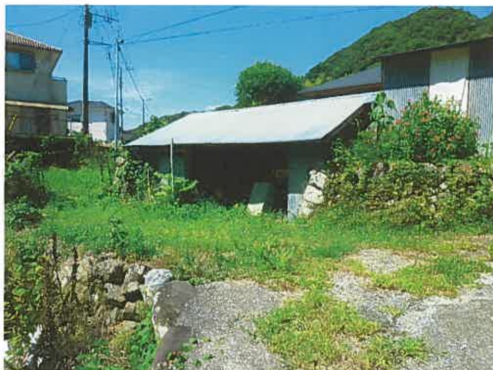
写真5 物件10土地上的下屋
