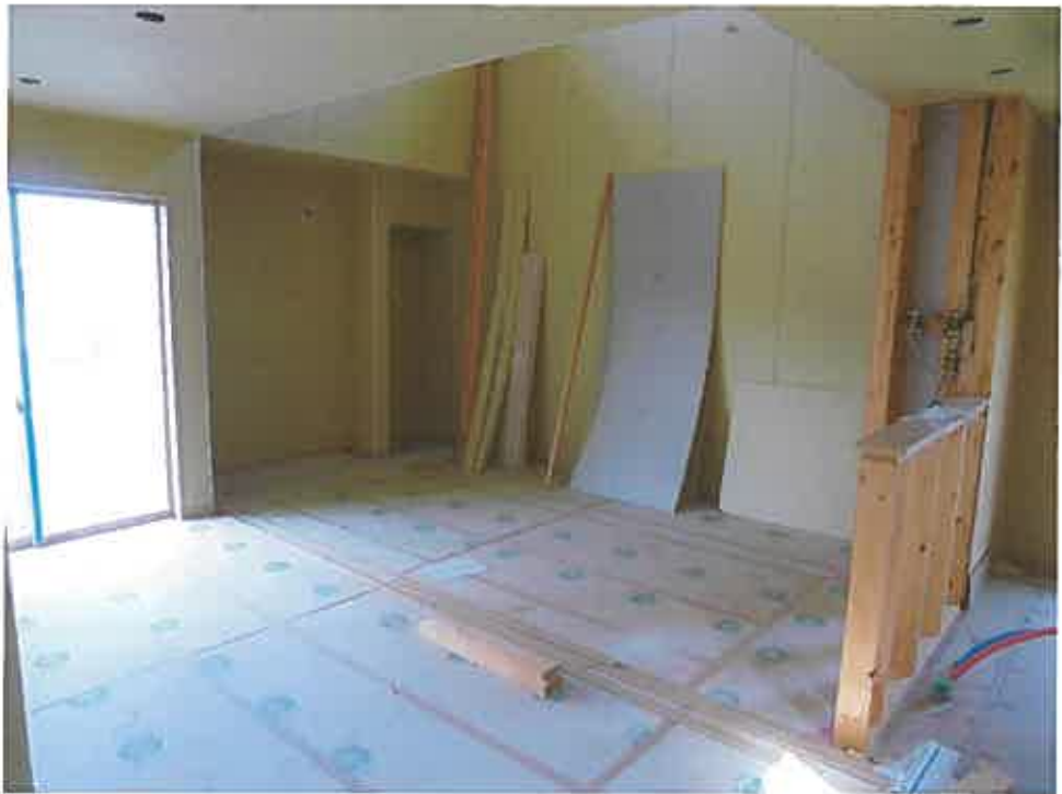
写真4 1階LDKから2階を撮影
