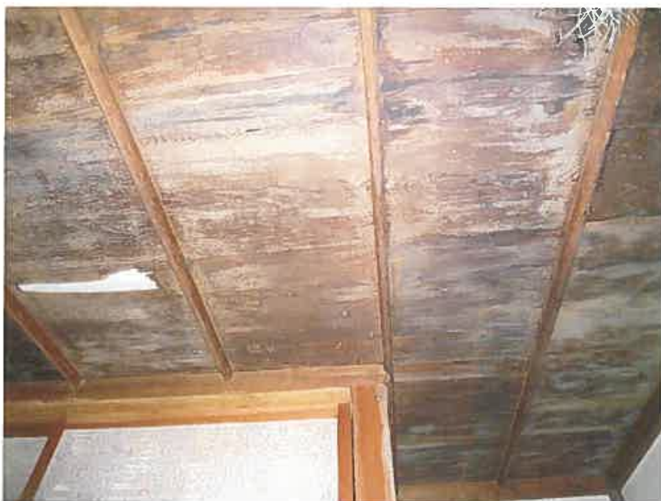
写真10 物件3主である建物1階の雨漏り跡
