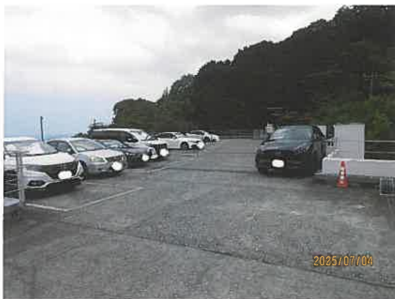
写真 1 0 本件マンション駐車場（屋上部分）
