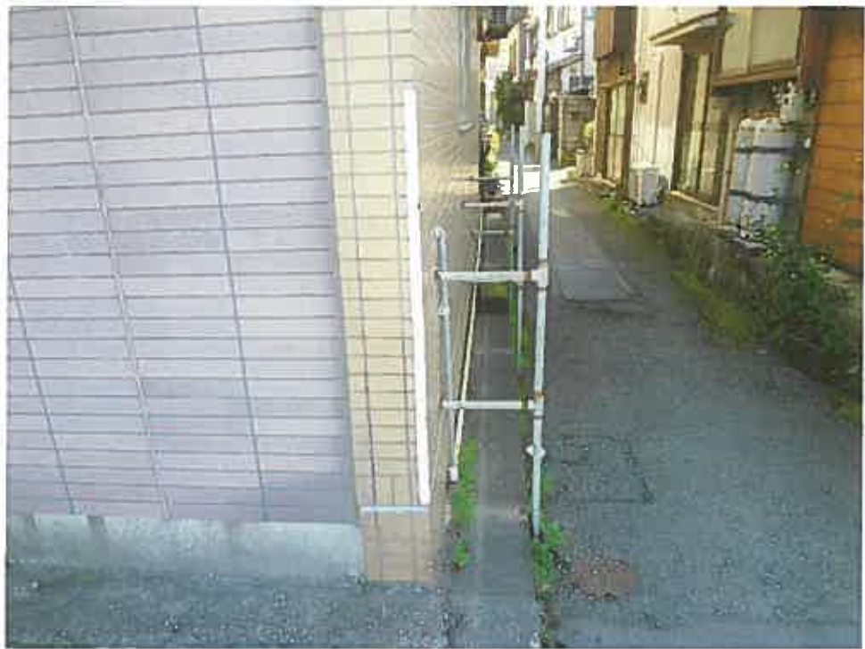
写真3 物件2建物南西角付近のパイプ置き
