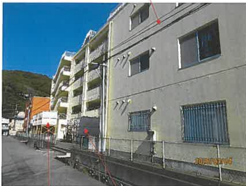
受水槽（上水） 受水槽（温泉）
