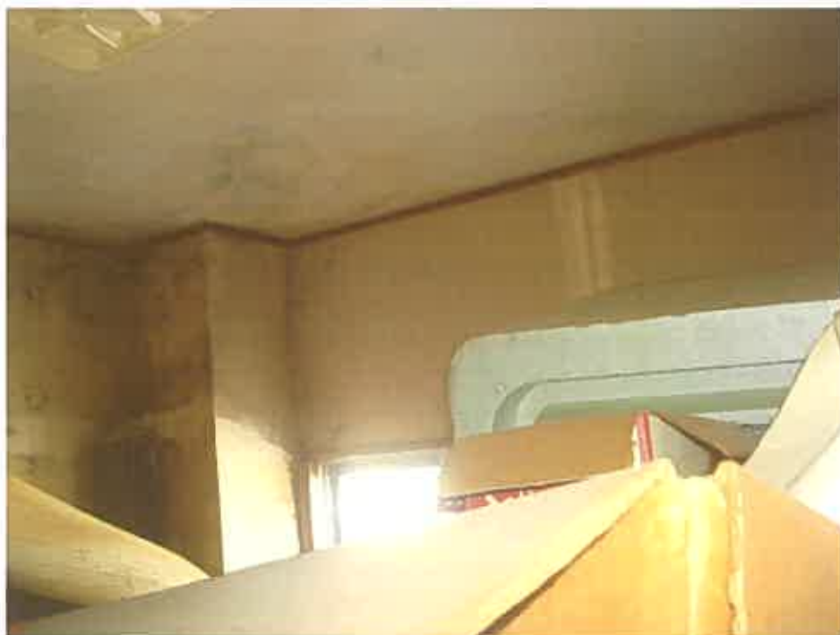
建物内の状況
