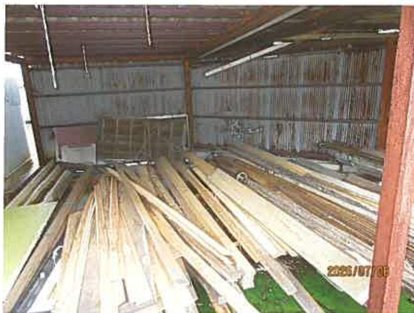
写真 2 3 物件 6 附属建物屋根上
