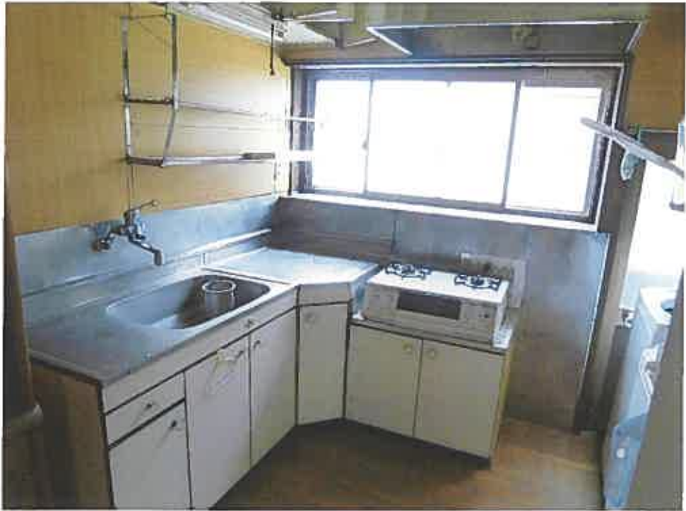
写真6 1階台所の壁の木板貼り付け状況
