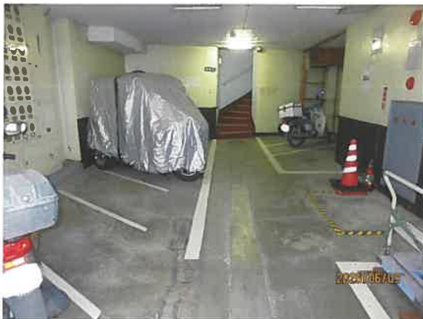
写真10 オートバイ置場（2号館）
