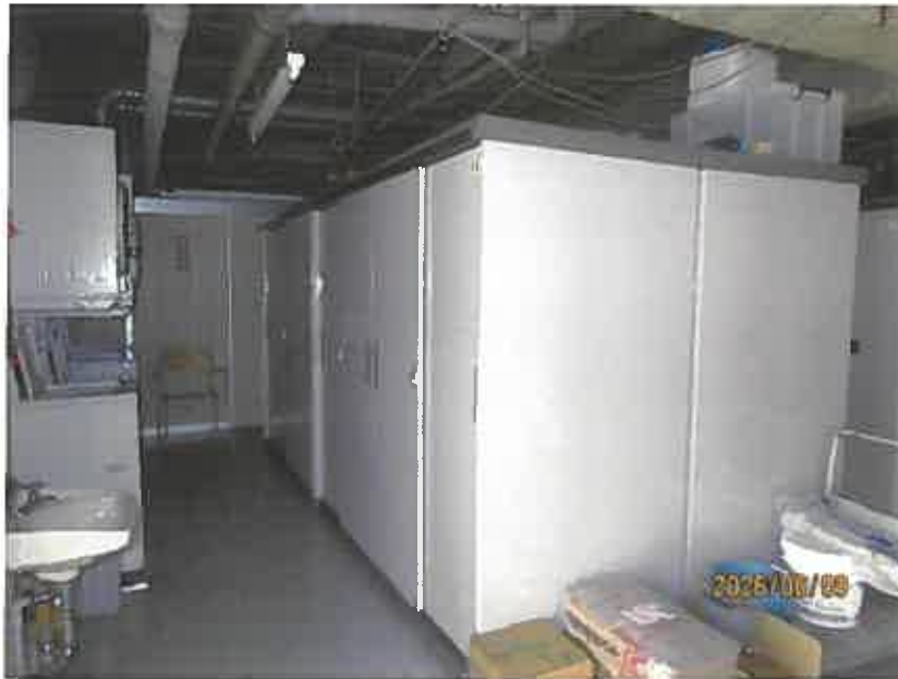
写真9 ランドリー・ロッカールーム（2号館）
