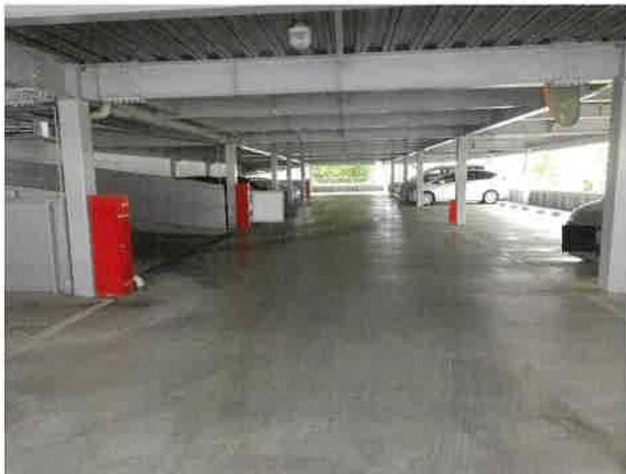
(3) 立体駐車場 (2階)
