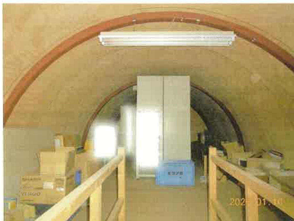
写真１８ 写真１２の階段式屋根裏収納内（撮影位置の図示は省略）
