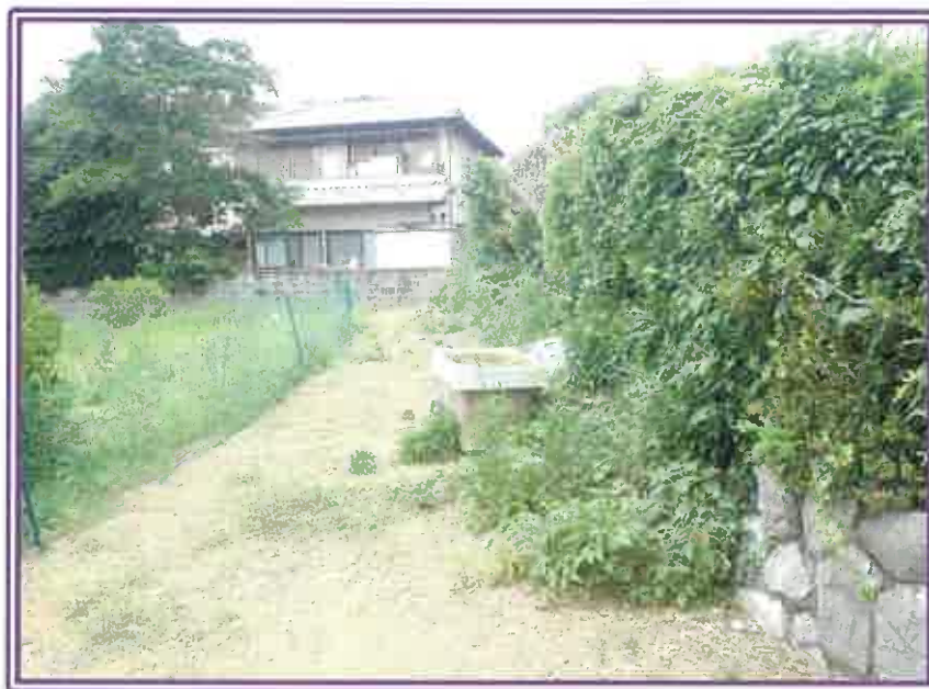
南西側隣地(1772-1)との境界付近
