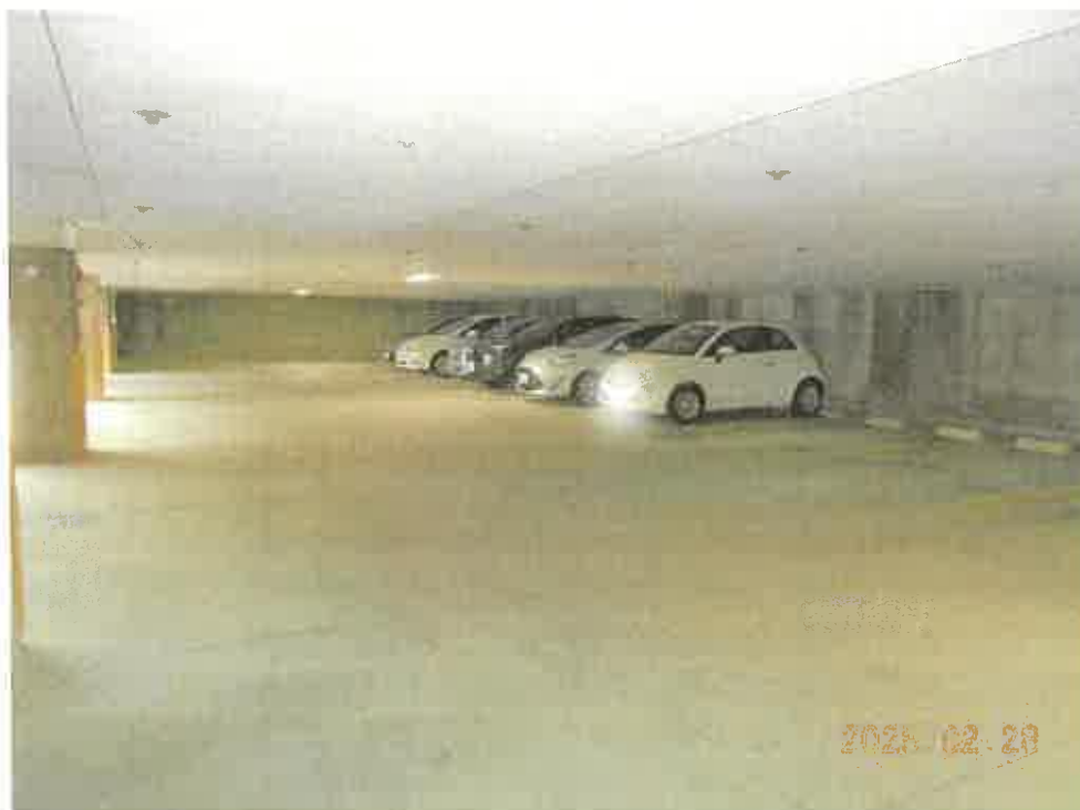
写真 6 敷地内駐車場（撮影位置の図示は省略）
