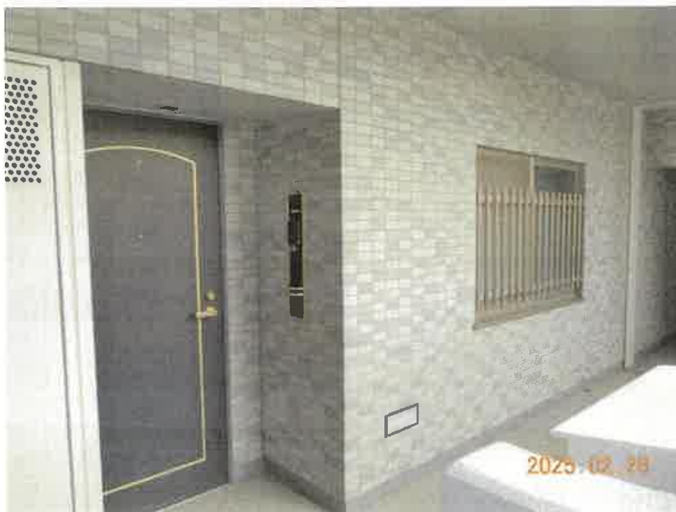
写真9 本件建物202号室
