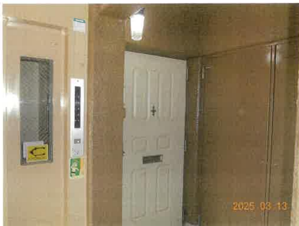
写真7 本件建物A-1号室
