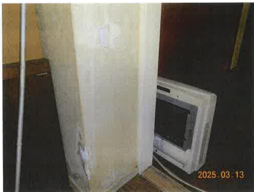
写真 1 7 本件建物南側洋室の内壁部分の引っ掻き傷跡（撮影位置の図示は省略）
