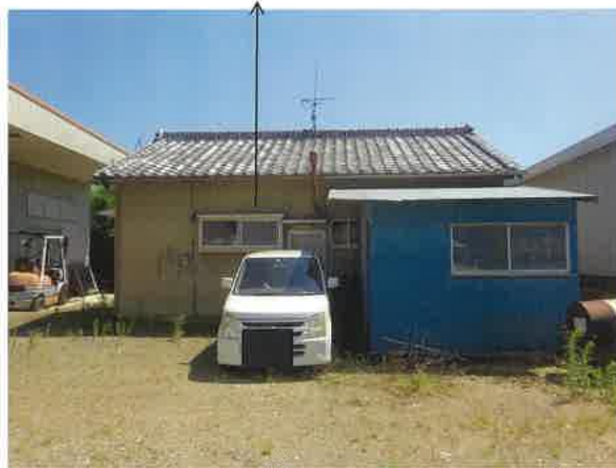
物件 5 未登記附属建物
