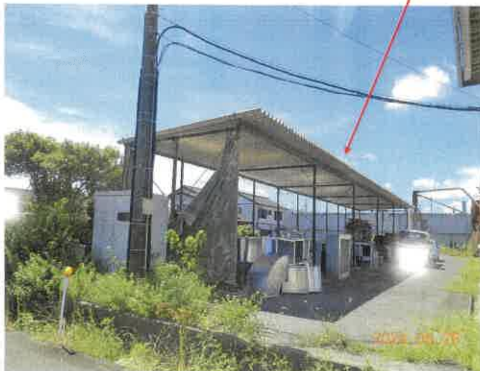
資材置場（構築物）
