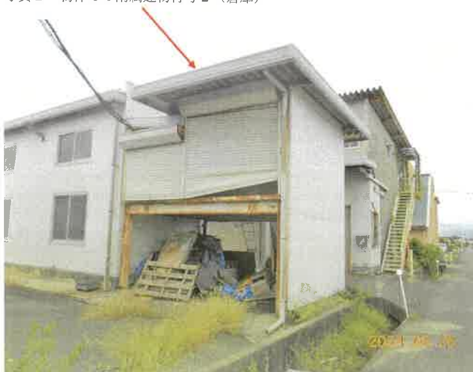
写真 2 物件 4 の附属建物符号 2 (倉庫)
