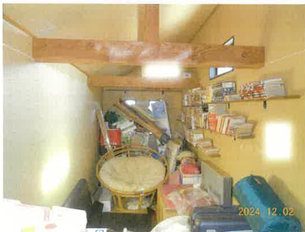
写真 3 2 屋根裏スペース
