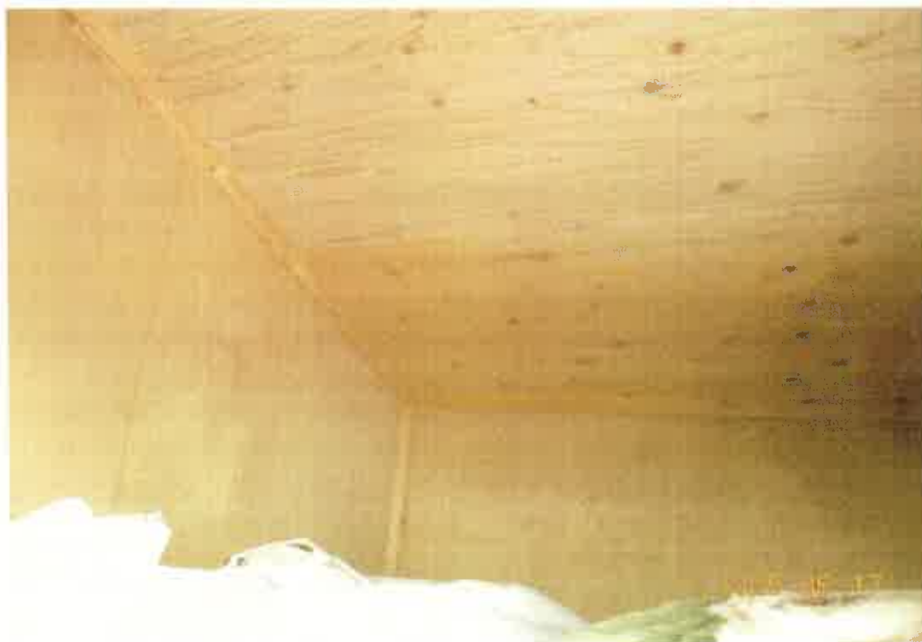
写真 3 0 前記写真 2 9 の天井裏の屋根裏収納内 (撮影位置の図示は省略)
