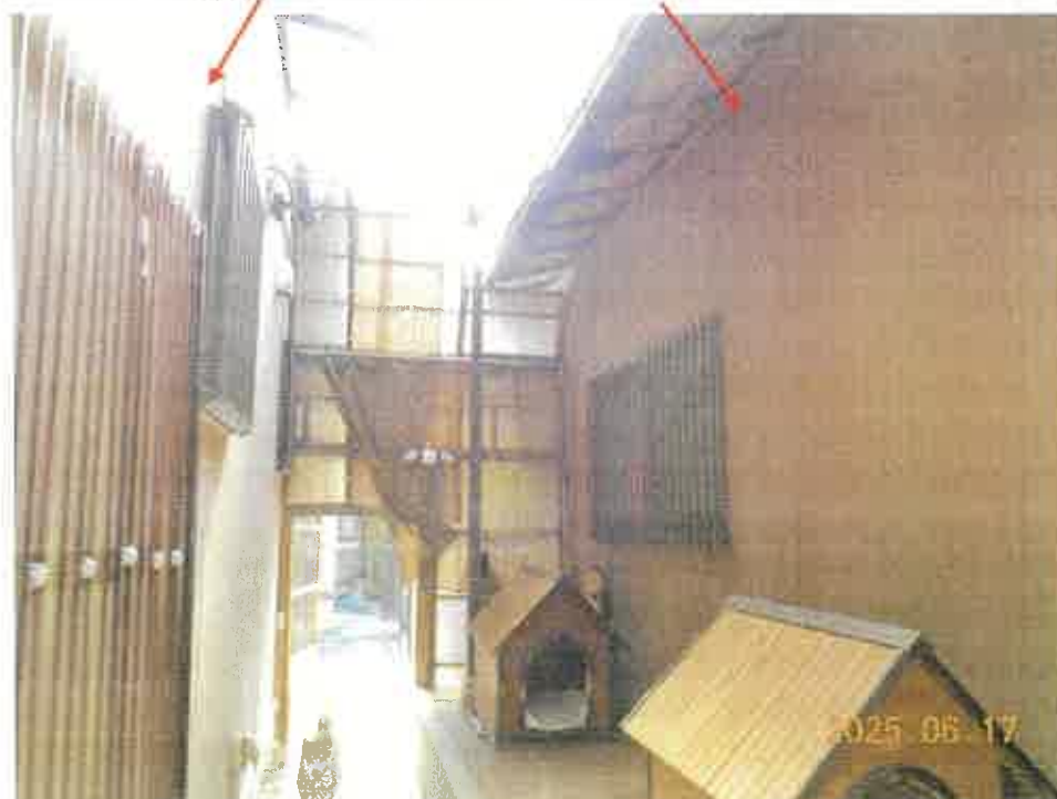
写真 1 2 物件 5 の附属建物符号 2 物件 5 の附属建物符号 1
