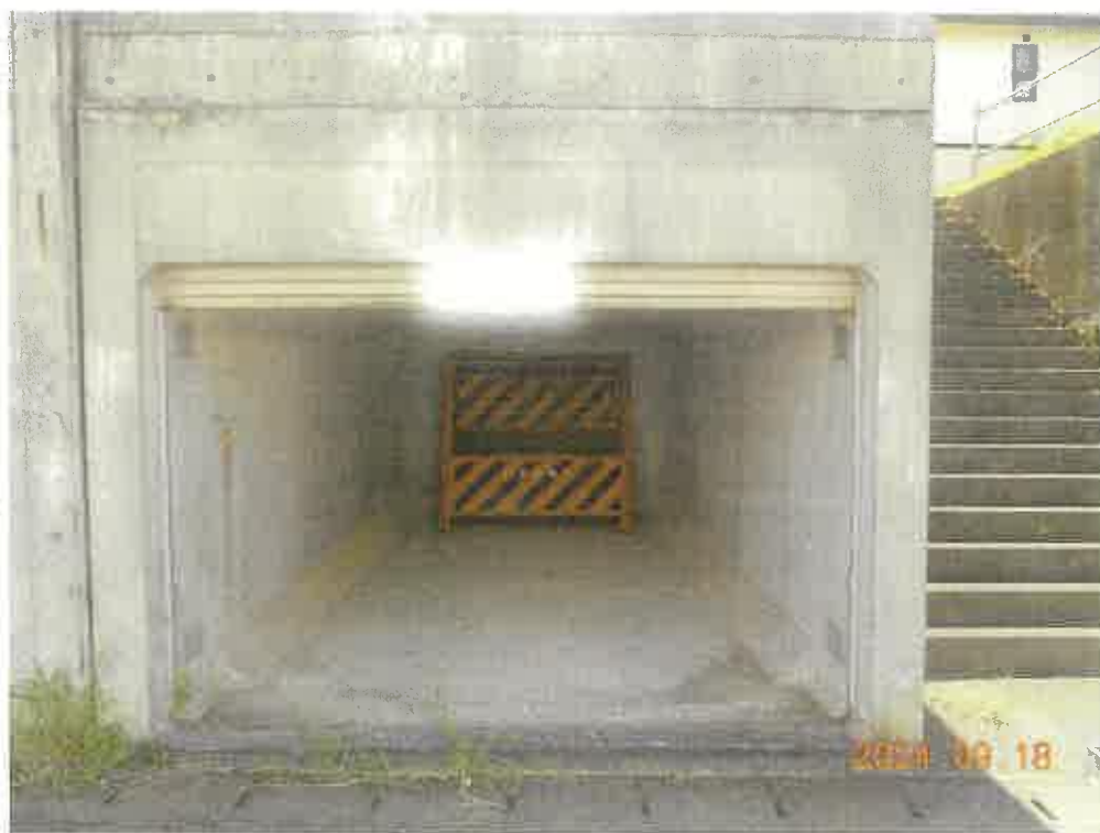
写真5 目的外建物（未登記・掘込車庫）
