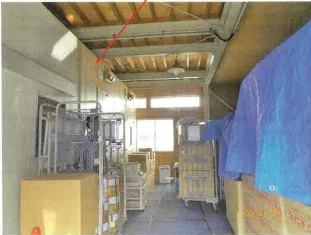
写真 2 3 物件 6 の建物内 クリーンルーム
