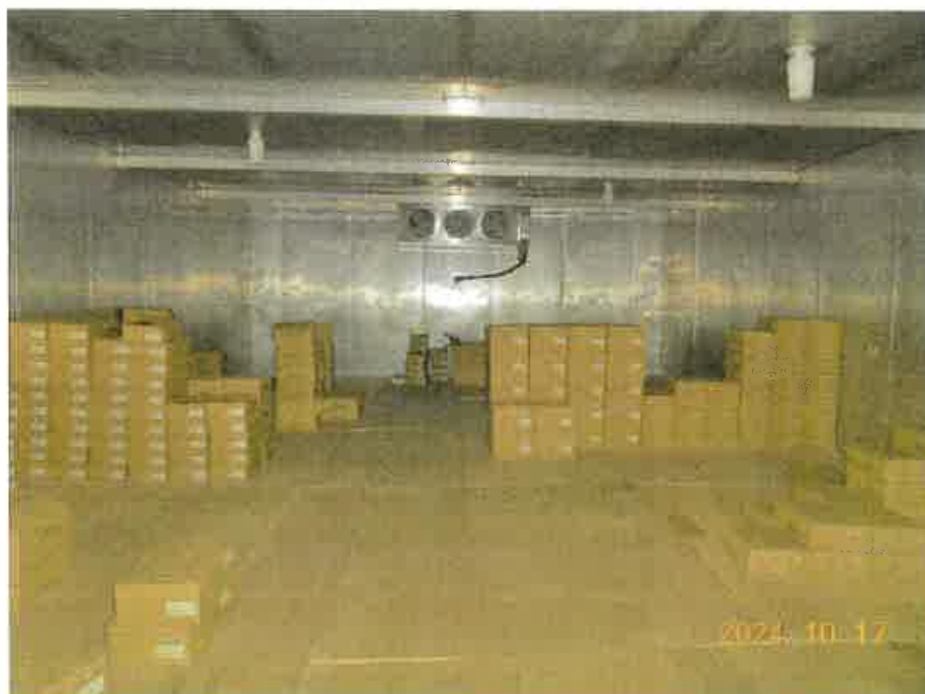
写真 3 0 写真 2 9 の冷蔵倉庫内
