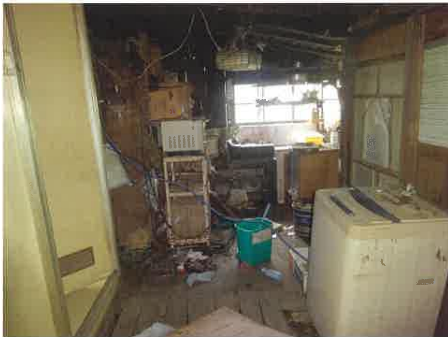
( 1 2 ) 物件 4 主たる建物
