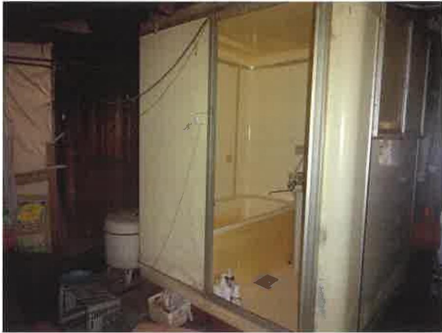
(13) 物件4主たる建物
