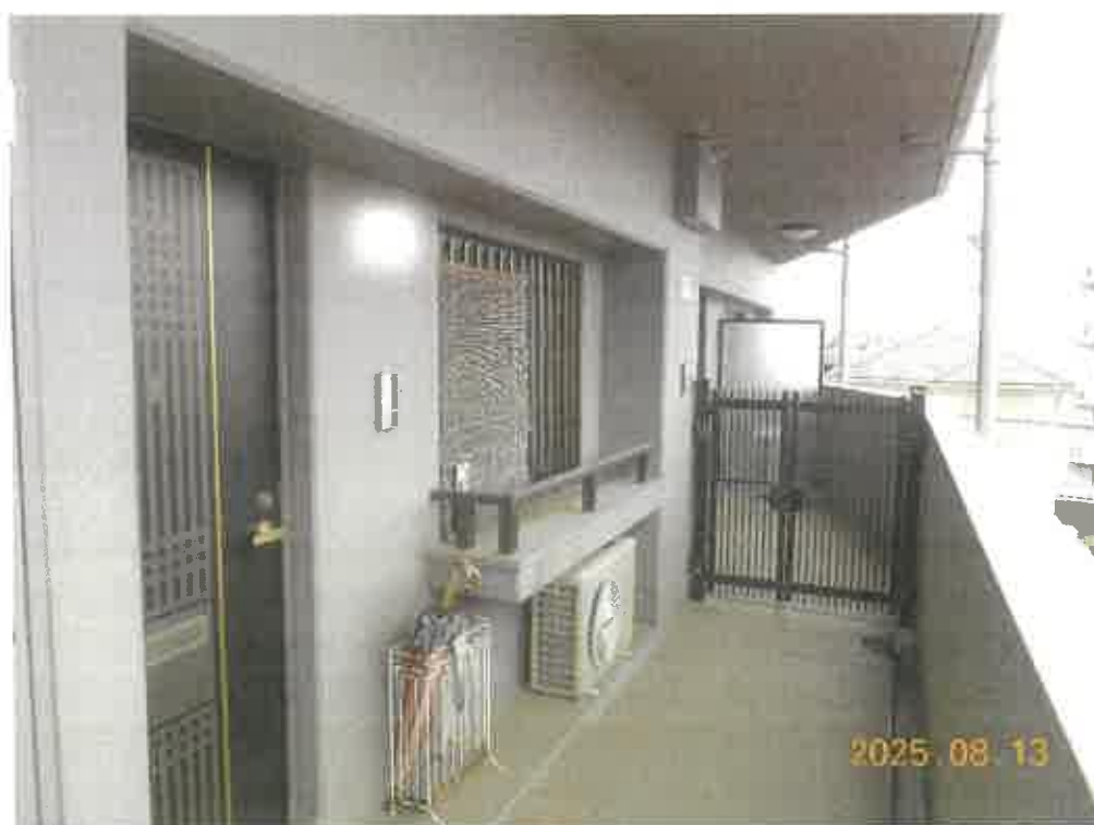
写真10 本件マンション302号室
