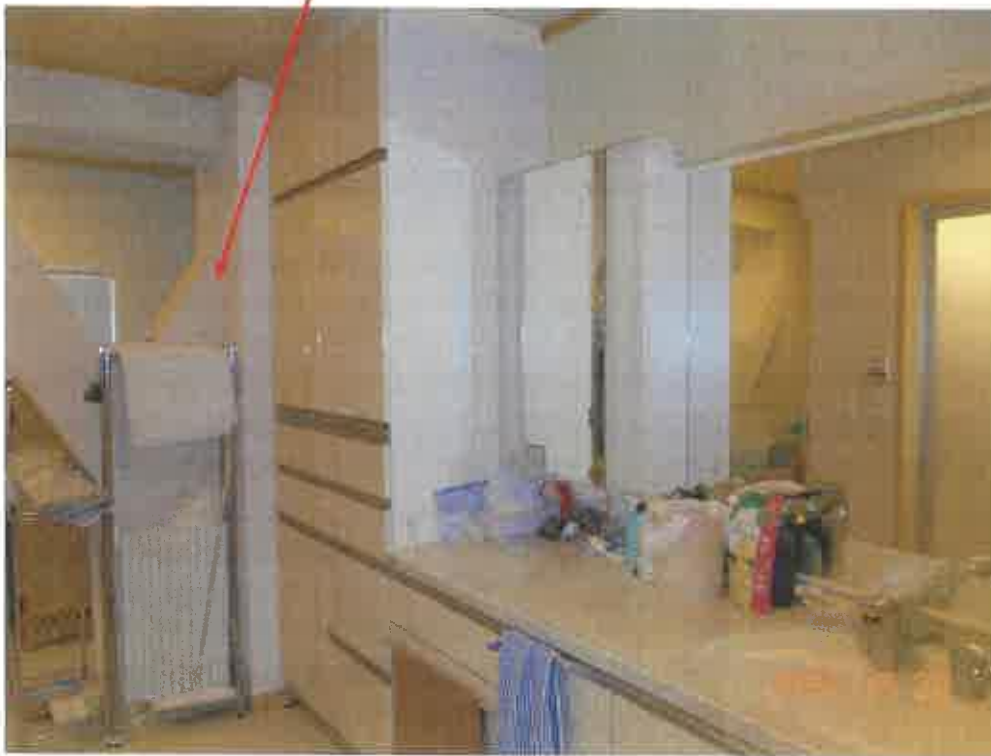
写真23 物件3の1階専有部の洗面所及び便所付近の耐震補強箇所
