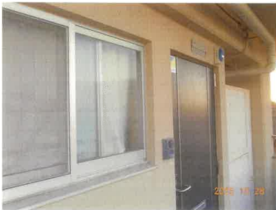
写真1 本件マンション305号室（撮影位置の図示は省略）
