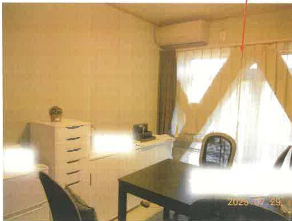
物件 3 の 1 階専有部の洋室の耐震補強箇所
