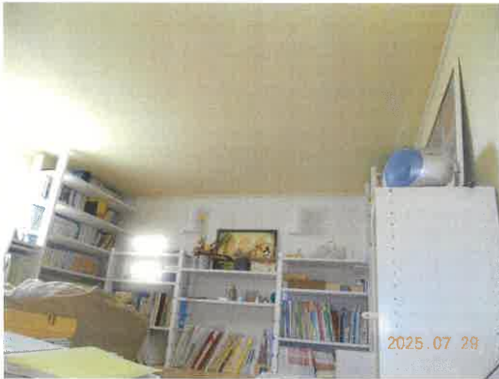
写真19 物件4の2階南西側洋室ロフト内（撮影位置の図示は省略）
