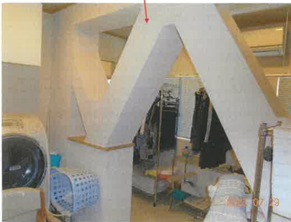
写真2 5 物件3の1階専有部の洗面所及び便所付近の耐震補強箇所
