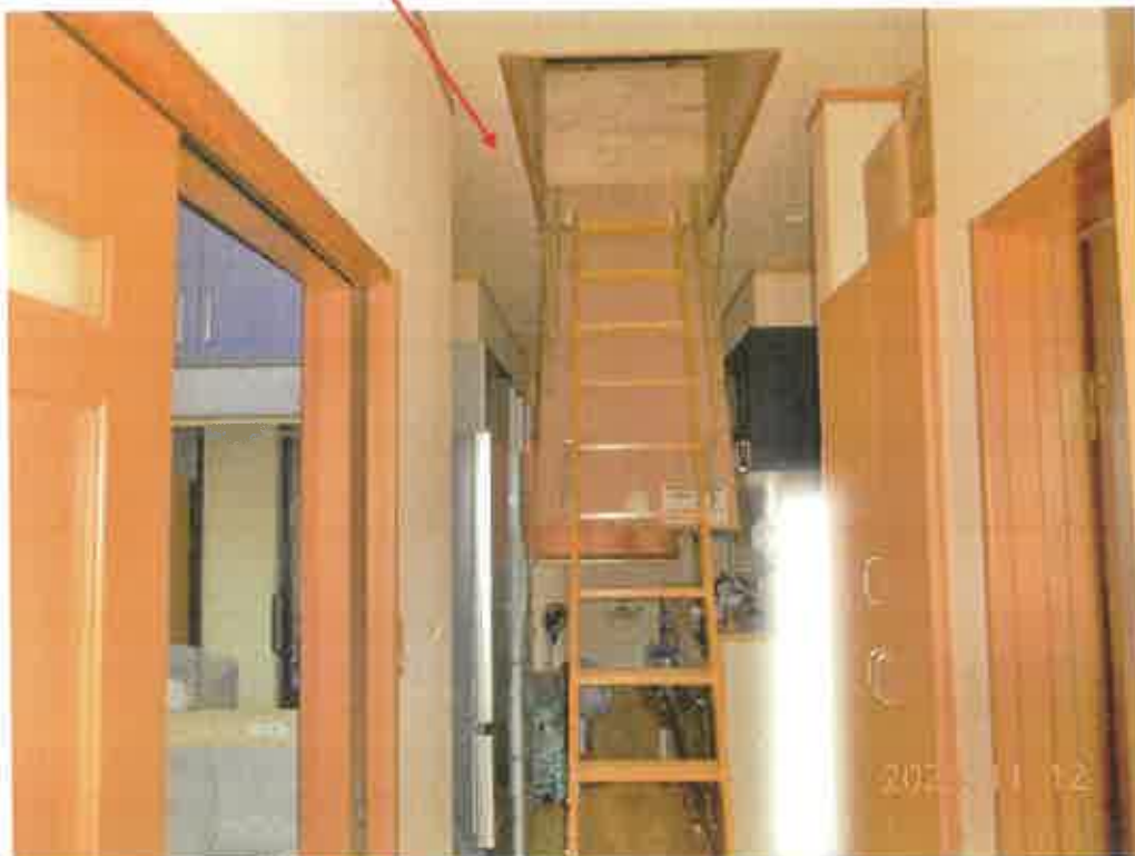
写真27 本件建物2階部分の階段式屋根裏収納
