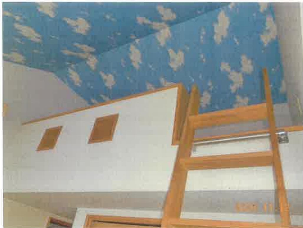
写真25 本件建物2階北側洋室のロフト（撮影位置の図示は省略）
