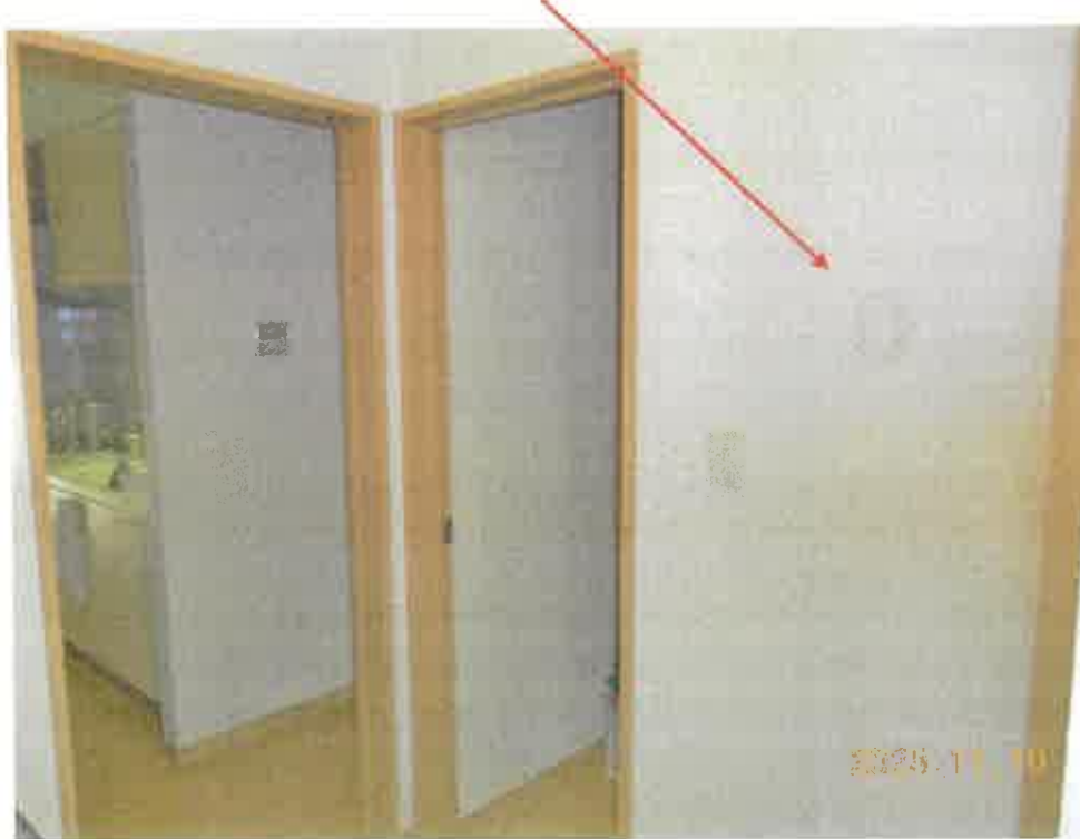
写真6 本件建物1階玄関付近の内壁の穴の補修跡
