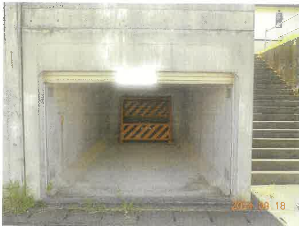
写真5 目的外建物（未登記・掘込車庫）
