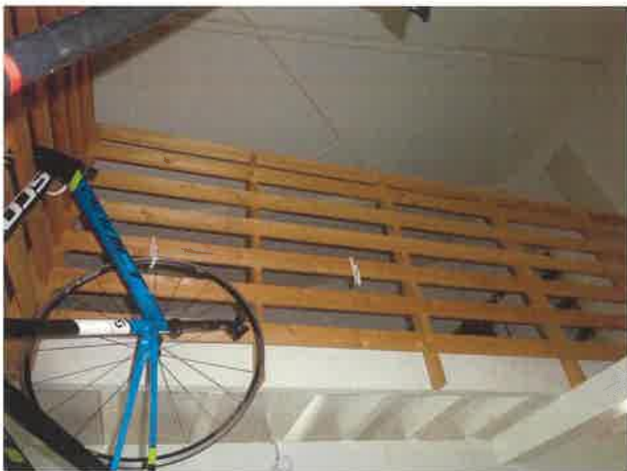
(14) 物件3 (ロフト (収納スペース))
