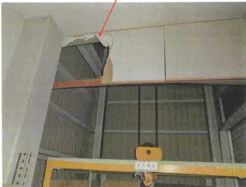
写真19 1階北西側倉庫部分の内壁の破損箇所（撮影位置の図示は省略）
