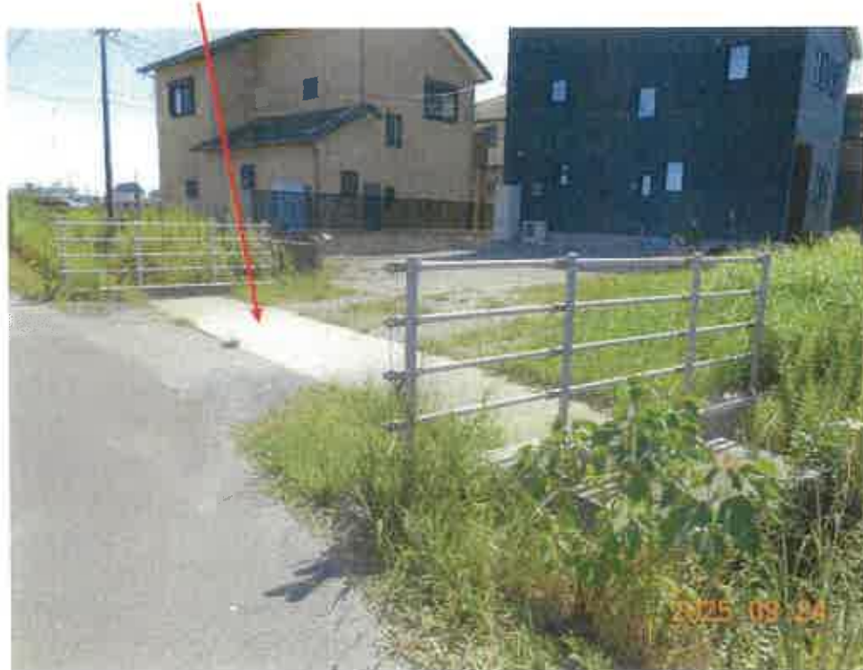
写真1 コンクリート橋
