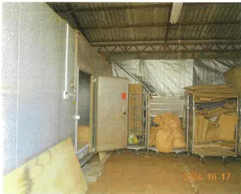
写真29 物件6附属建物符号1の冷蔵倉庫
