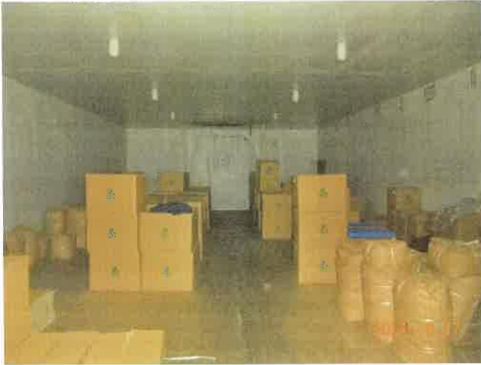
写真 2 5 物件 6 の建物内の冷蔵倉庫内
