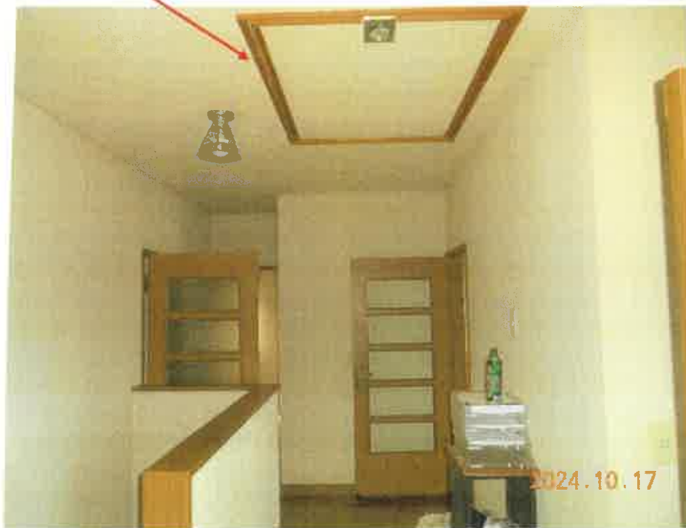
写真19 階段式屋根裏収納
