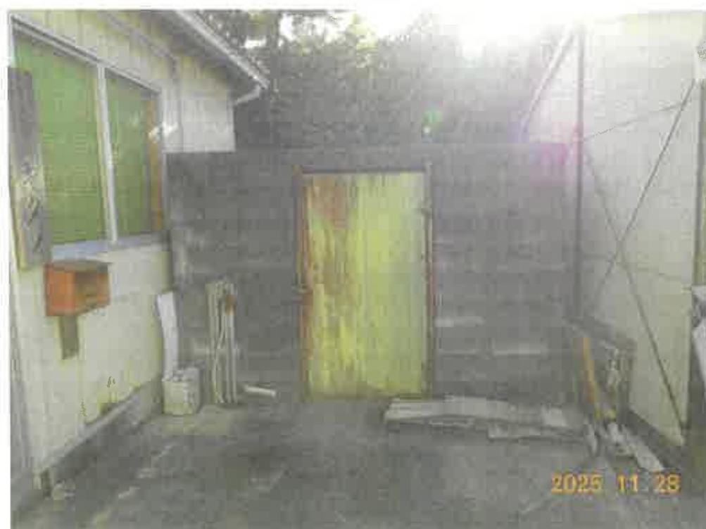
写真10 物件7の附属建物符号1（機械室）
