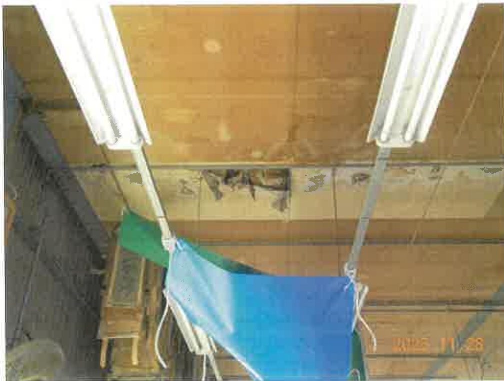
写真 2 1 物件 7 の建物の天井部分の損傷部分及び雨漏り跡（撮影位置の図示は省略）
