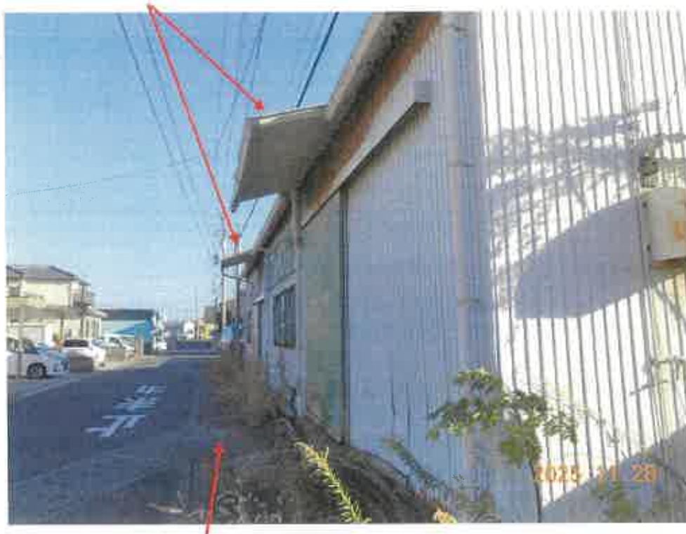
暗渠水路部分
