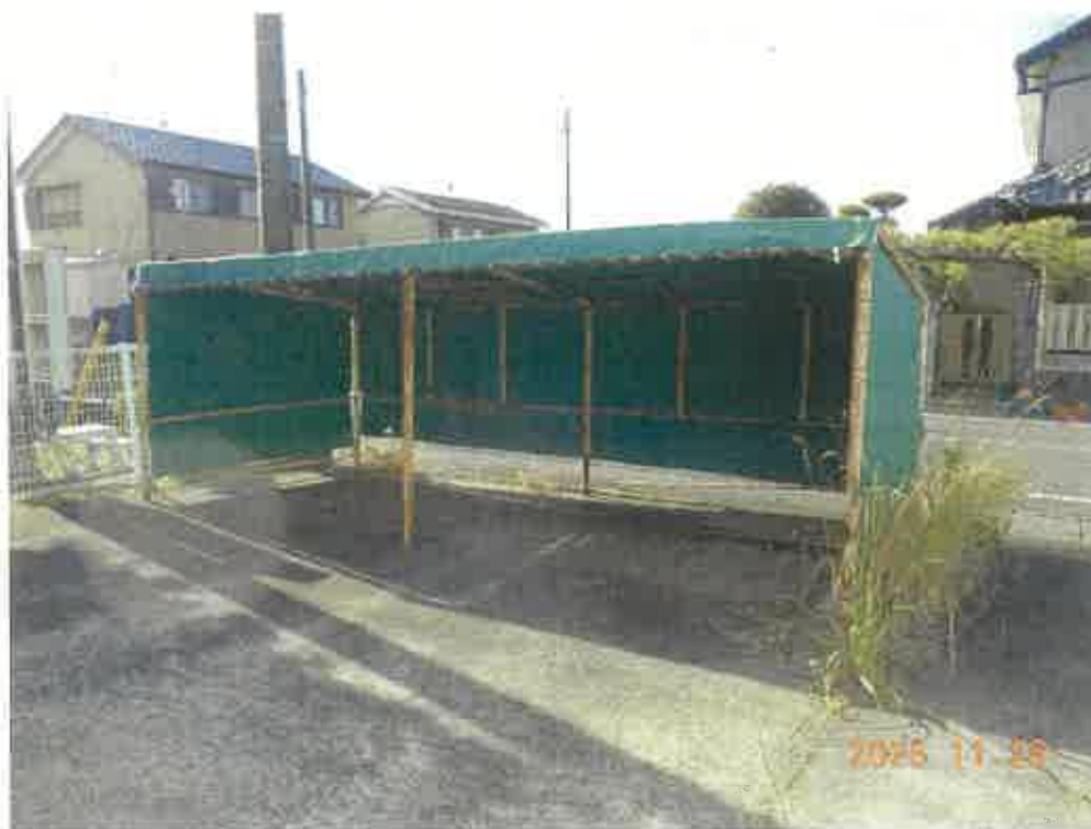
写真9 構築物（自転車置場）
