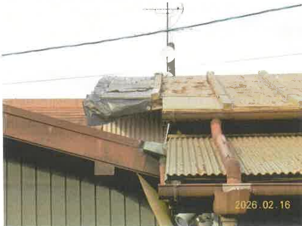
写真8 本件建物の屋根の雨漏り箇所の補修部分（撮影位置の図示は省略）
