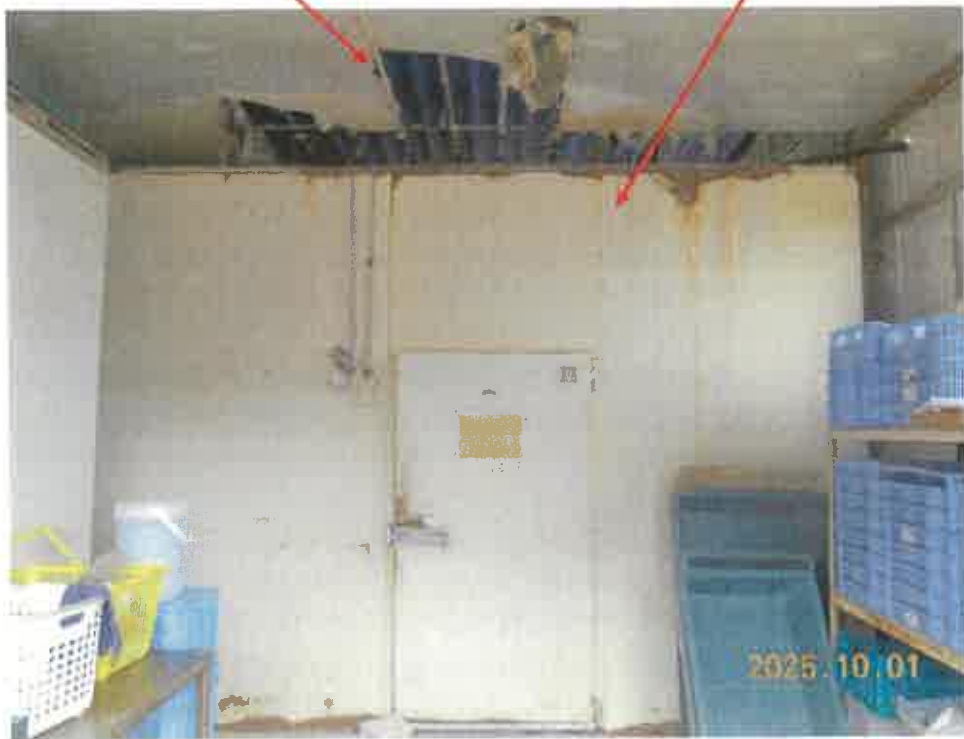
写真9 物件4の建物の天井部分の一部破損箇所
