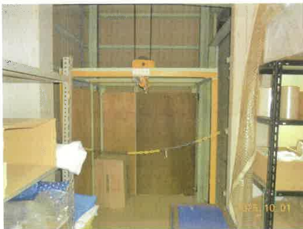
写真 1 8 1 階倉庫の荷物用エレベーター
