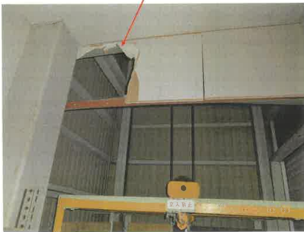
写真19 1階北西側倉庫部分の内壁の破損箇所（撮影位置の図示は省略）
