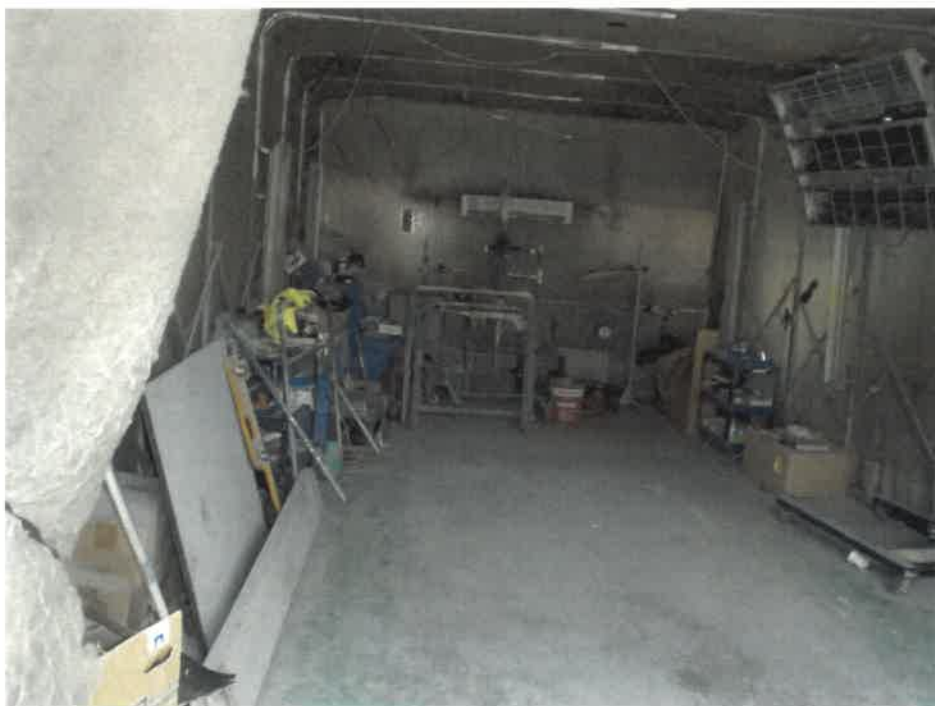
建物内の状況
