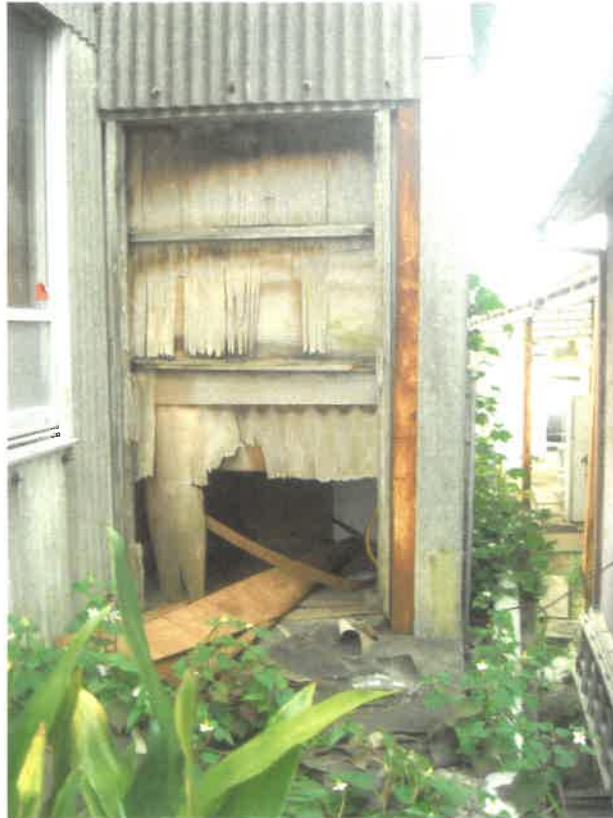
外便所の外扉
