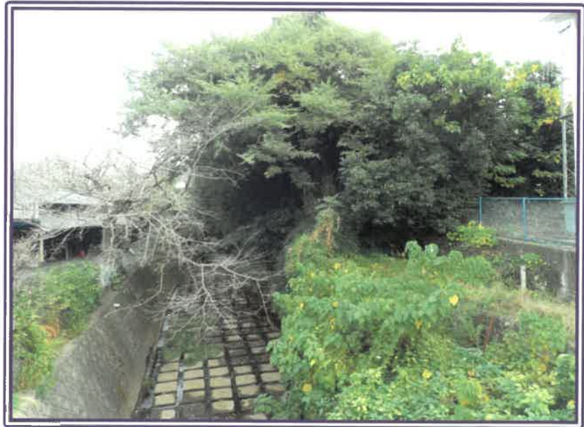
橋の上から物件2土地方向を撮影
