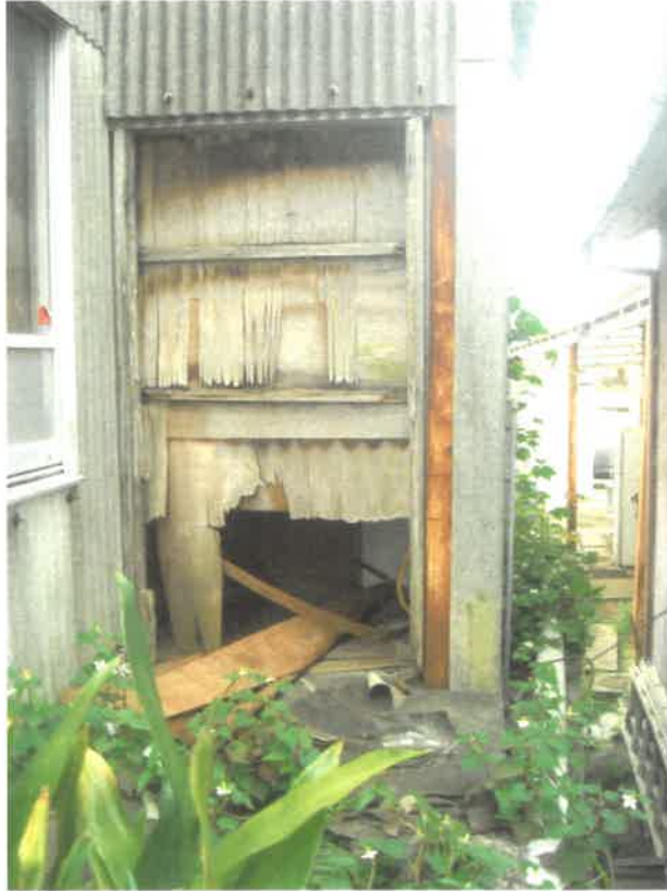
外便所の外扉
