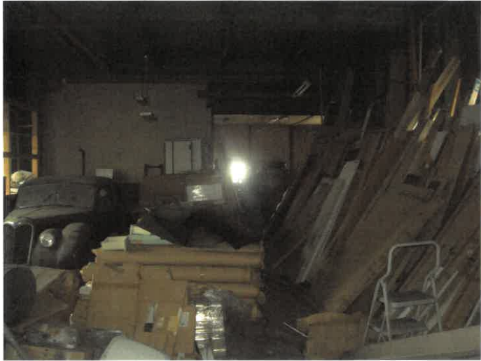
建物内の状況
