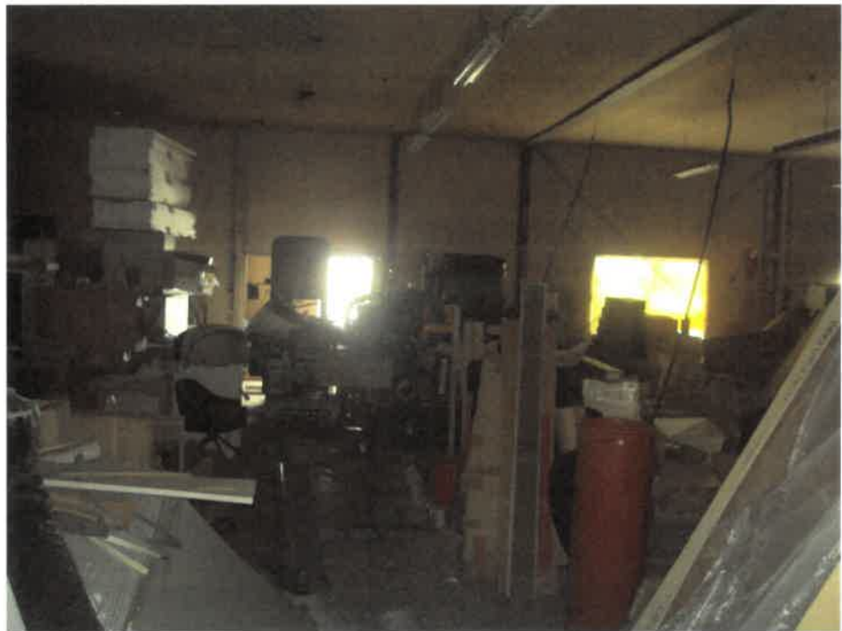
建物内の状況
