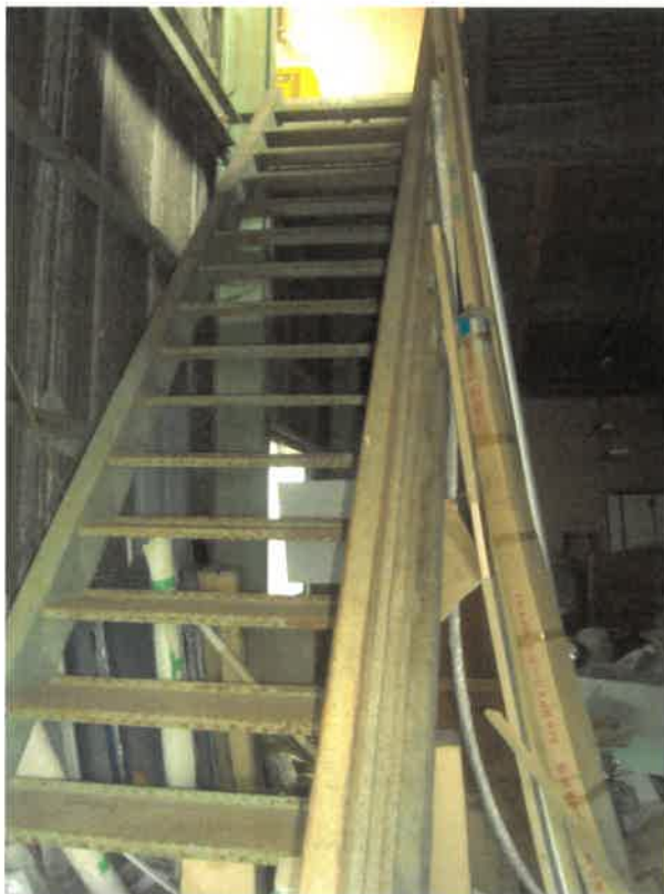
建物内の状況
