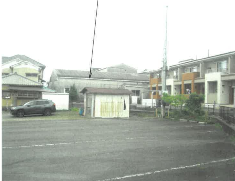
写真 6 物件 3 主たる建物
