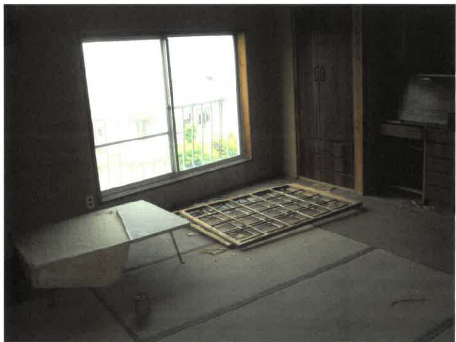
建物内の状況
