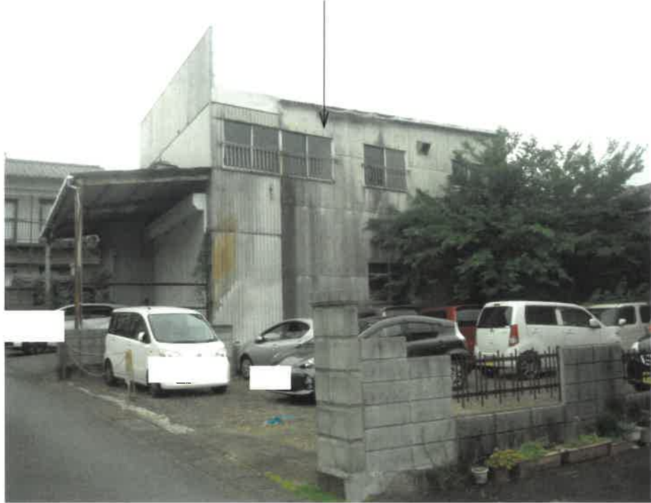
物件 3 附属建物
