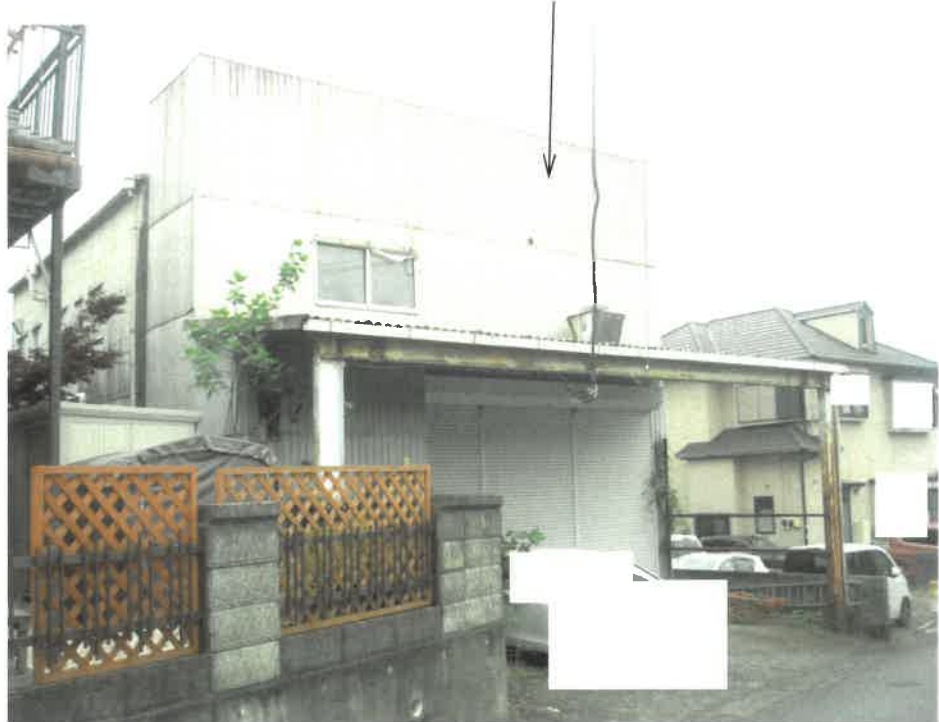
物件 3 附属建物
