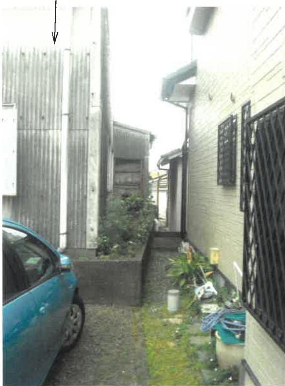
写真 5 物件 3 主たる建物
