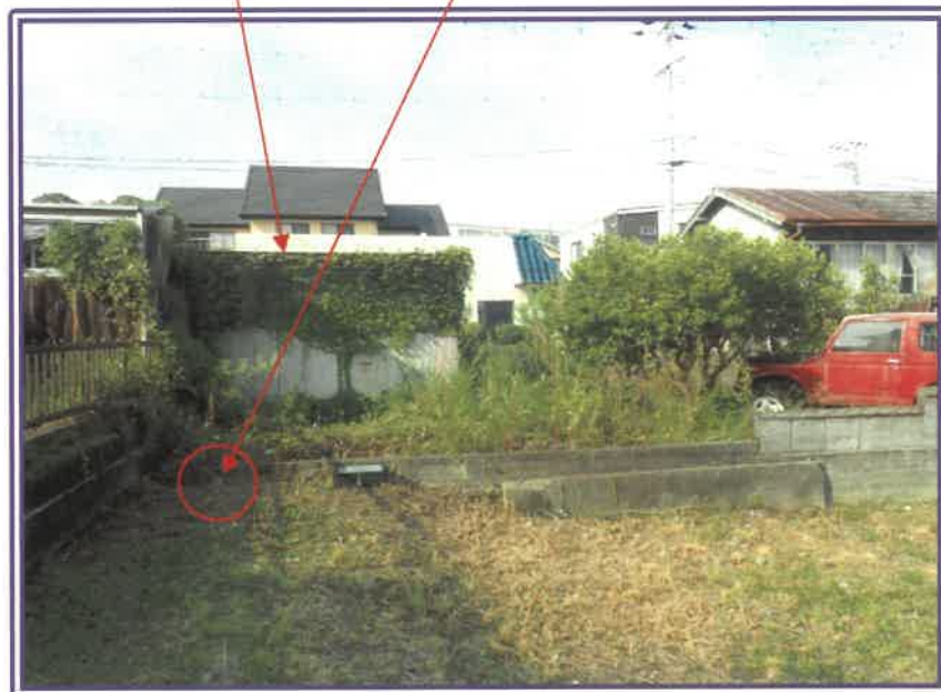
境界標様の杭
