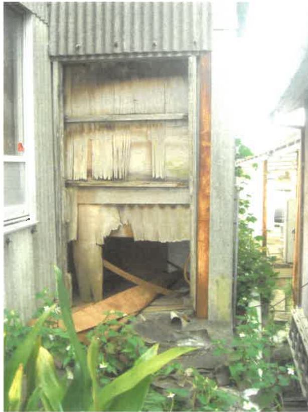
外便所の外扉
