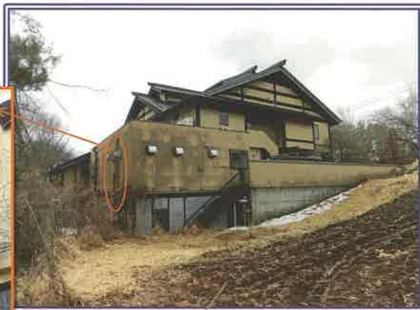
北棟の北側遠景
