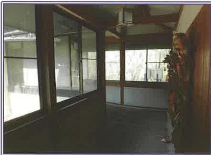
北棟（奥）への渡り廊下（南棟）
