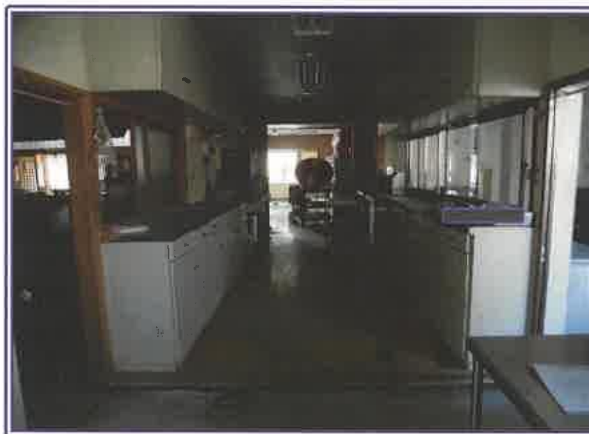
配膳スペース（北棟・1階）
