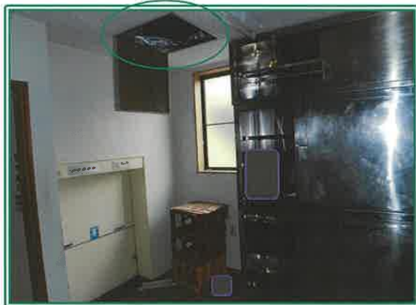
配膳室（北棟・2階）
