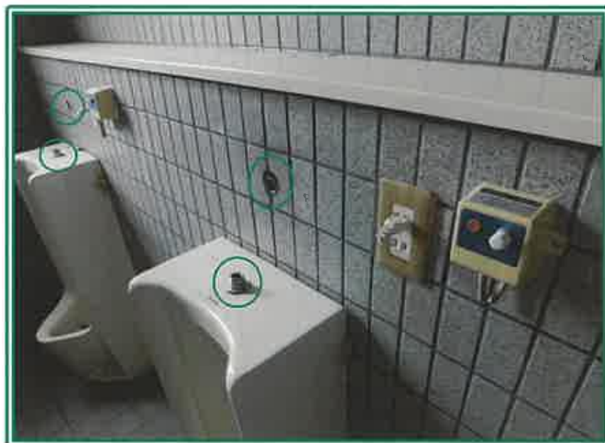
トイレ（北棟・1階）
