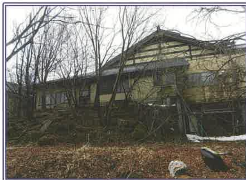
北棟の東側近景
