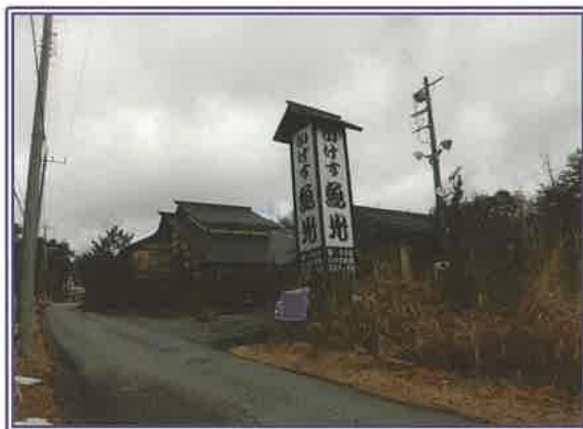
本件店舗の西側遠景
