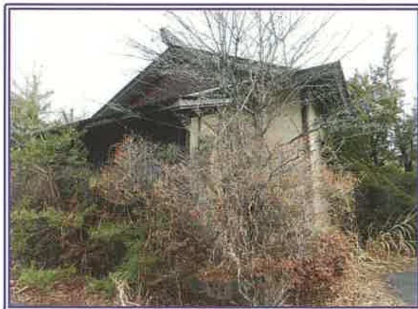
南棟の西側近景
