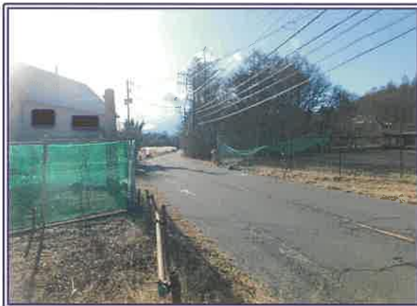
国道（413号線・道志みち）の状況
