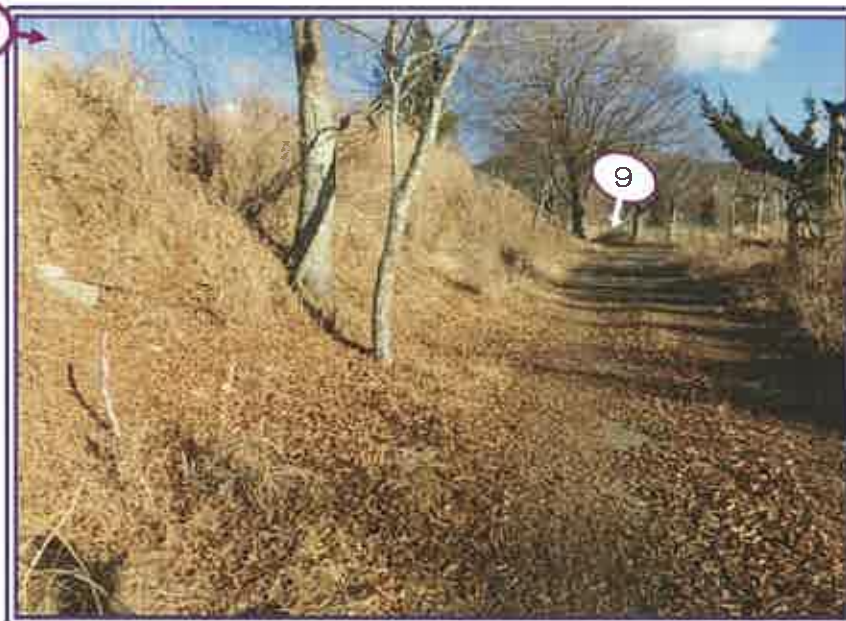
南側境界付近の状況（本件土地は 左側の法面側）
