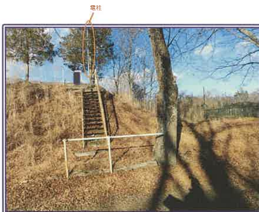
南東角境界付近の状況
