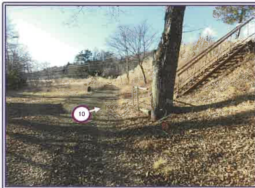
南側境界付近の状況（本件土地は右側の法面側）
