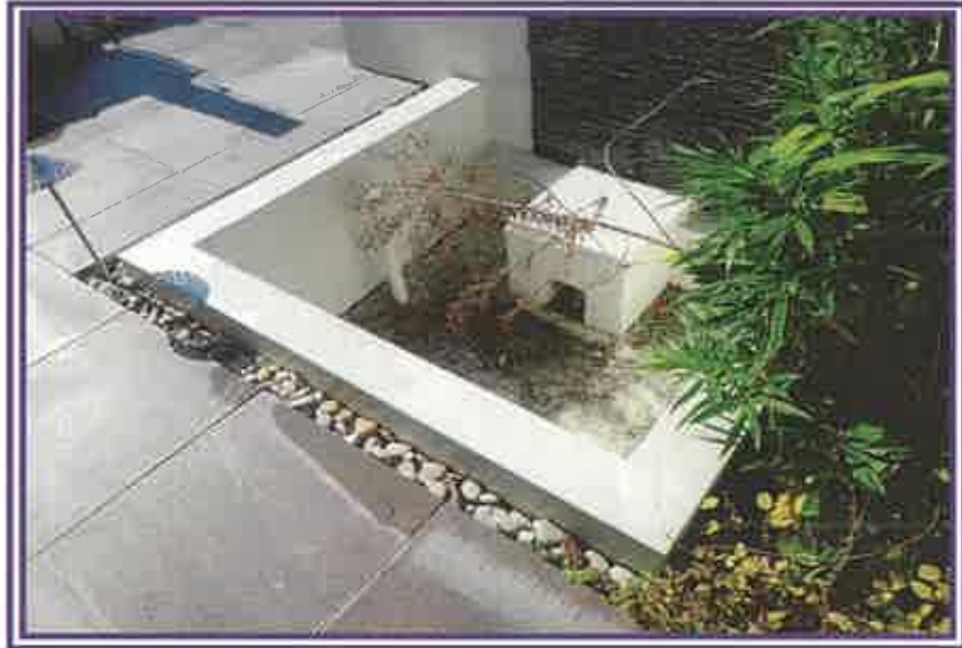
エントランス付近に設置されている水槽様の構造物及びその周辺を撮影したもの
