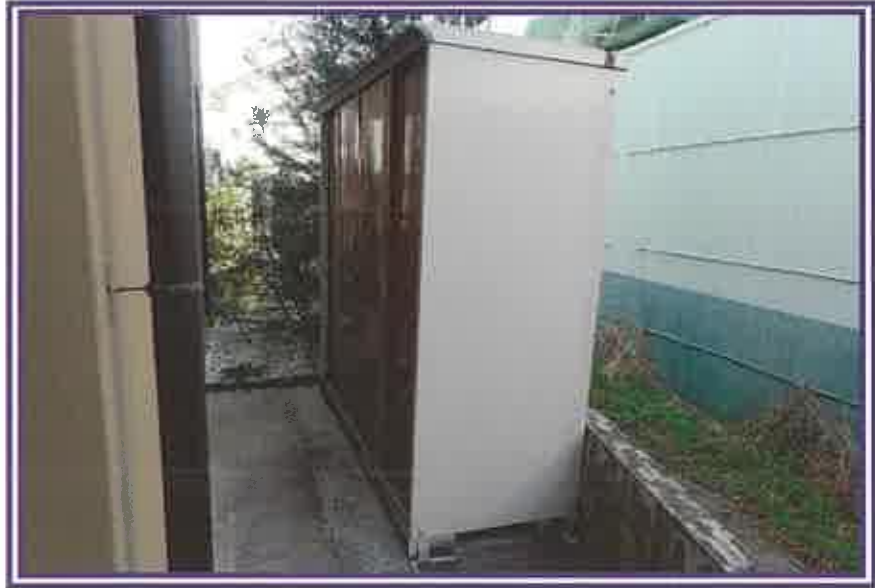
物置及びその周辺を撮影したもの
