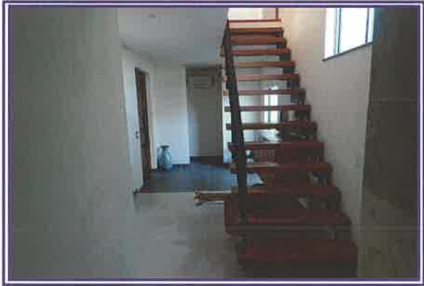
1階から、階段方向を撮影したもの
