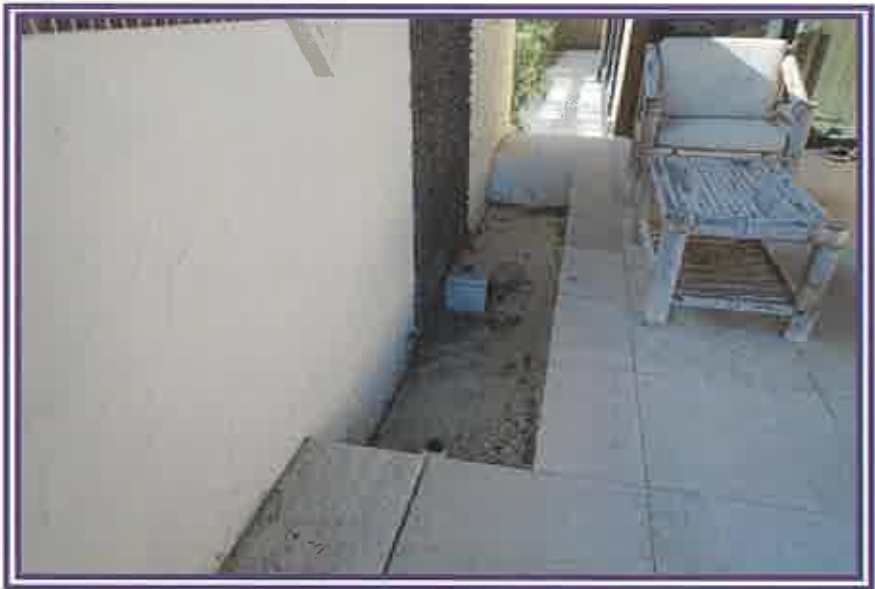
タイルテラス内にある、水槽様の箇所を撮影したもの
