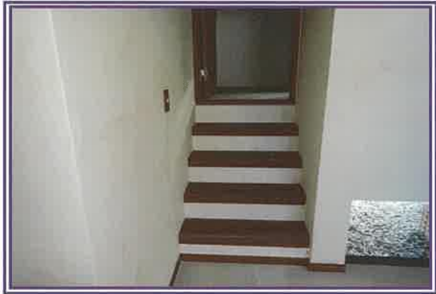
書斎に通じる階段方向を撮影したもの
