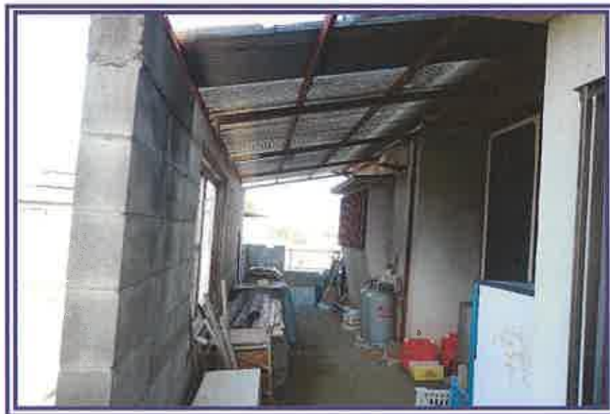
下屋内部を撮影したもの
