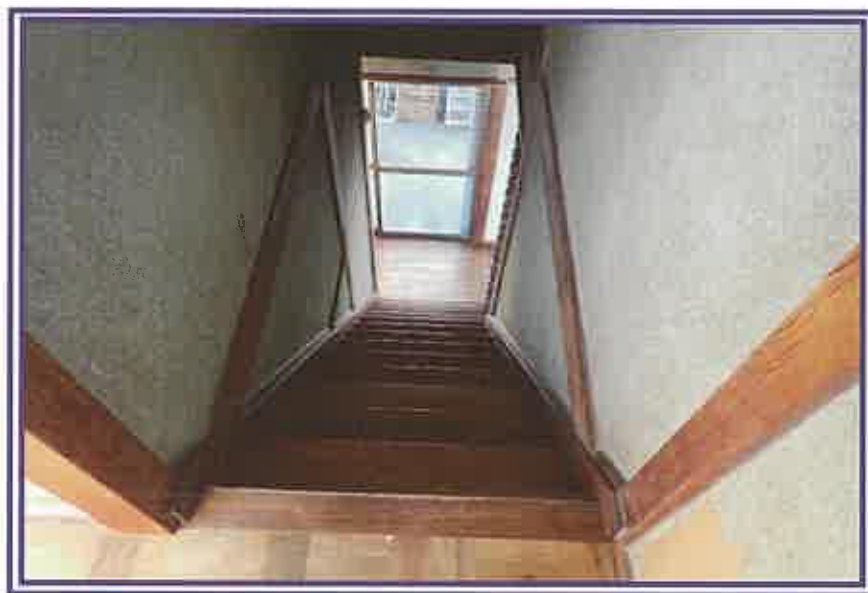
2階から階段方向を撮影したもの
