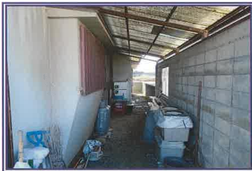
下屋内部を撮影したもの
