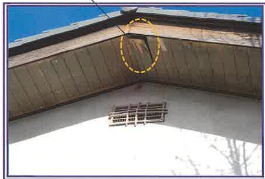
軒天の損傷箇所を撮影したもの
