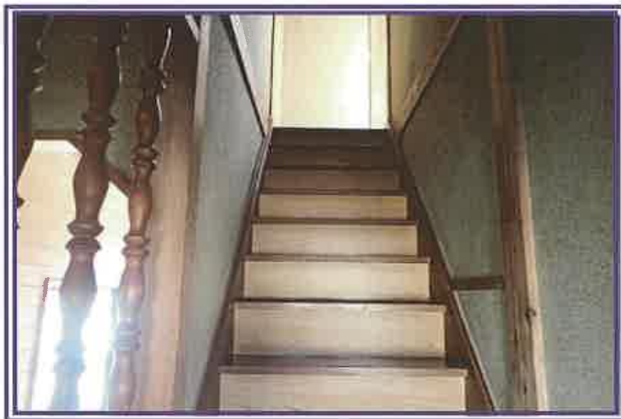
1階から階段方向を撮影したもの
