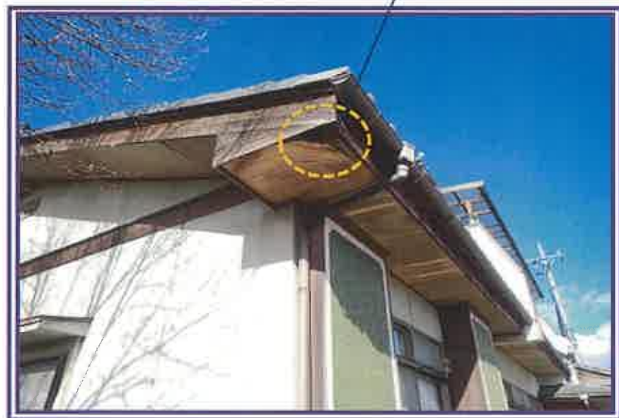
軒天の損傷箇所を撮影したもの
