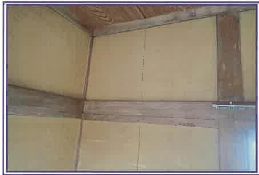
壁に損傷(亀裂)が認められる状況を撮影したもの(和室5)
