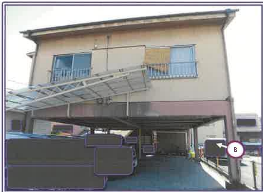
物件3の居宅の道路側近景
