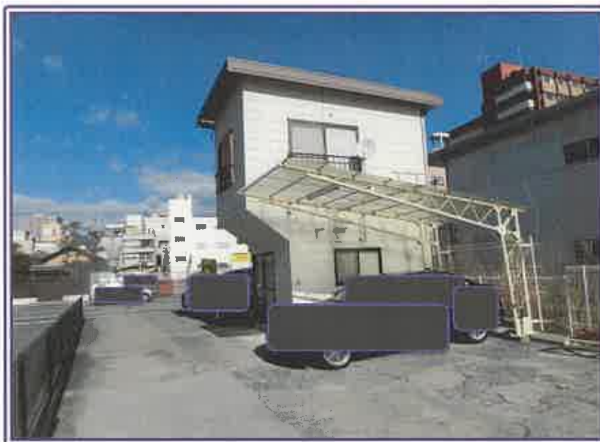
物件2の事務所・休憩所の裏側近景
