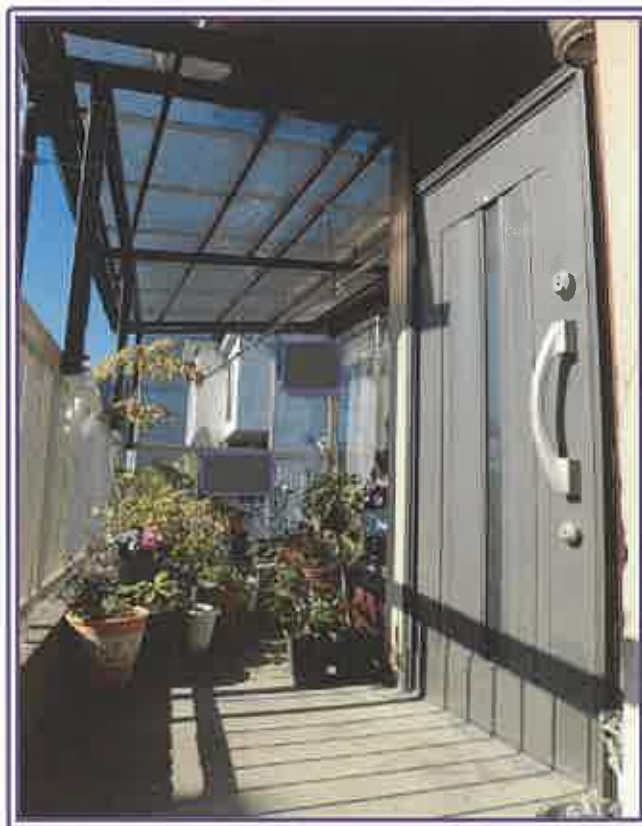
物件3の居宅の玄関前（奥はバルコニー）
