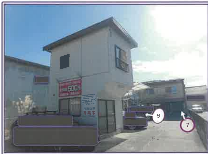
物件2の事務所・休憩所の道路側近景
