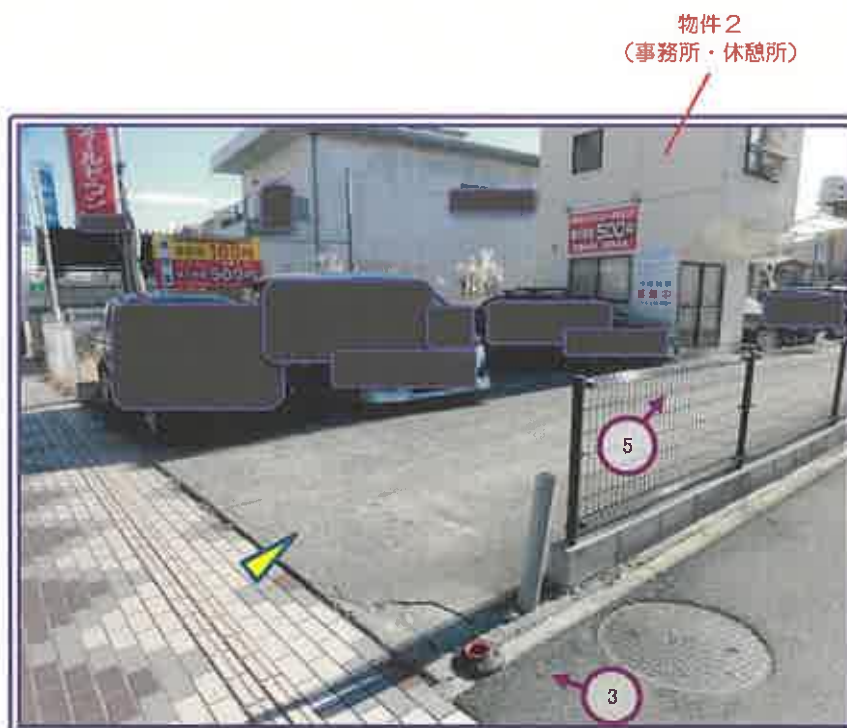
駐車場(道路側)の状況
