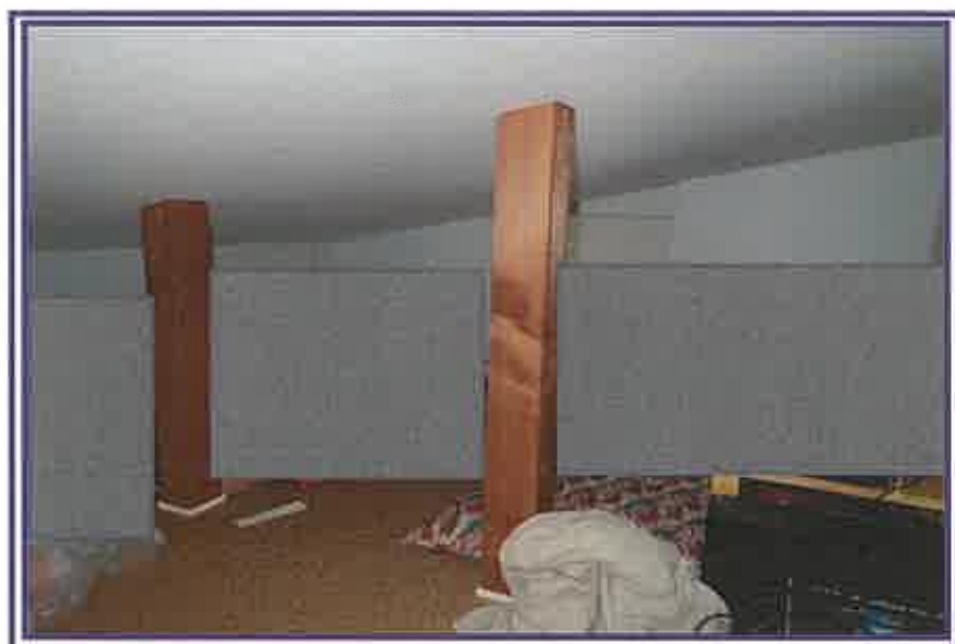
屋根裏(ロフト部分)
