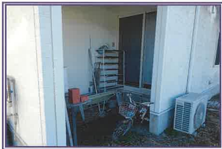
本件建物の1階北東側付近を撮影したもの
