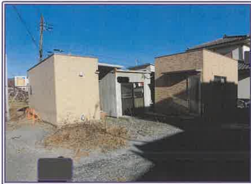
本件土地上の各建設事務所（いずれも仮設構築物）
