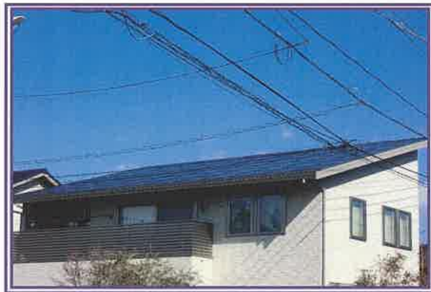
本件建物の屋根に、ソーラーパネルが設置されている状況を撮影したもの
