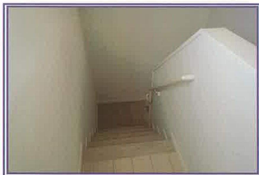
2階から、階段方向を撮影したもの
