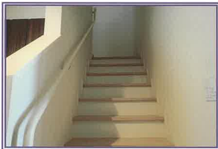
1階から、階段方向を撮影したもの
